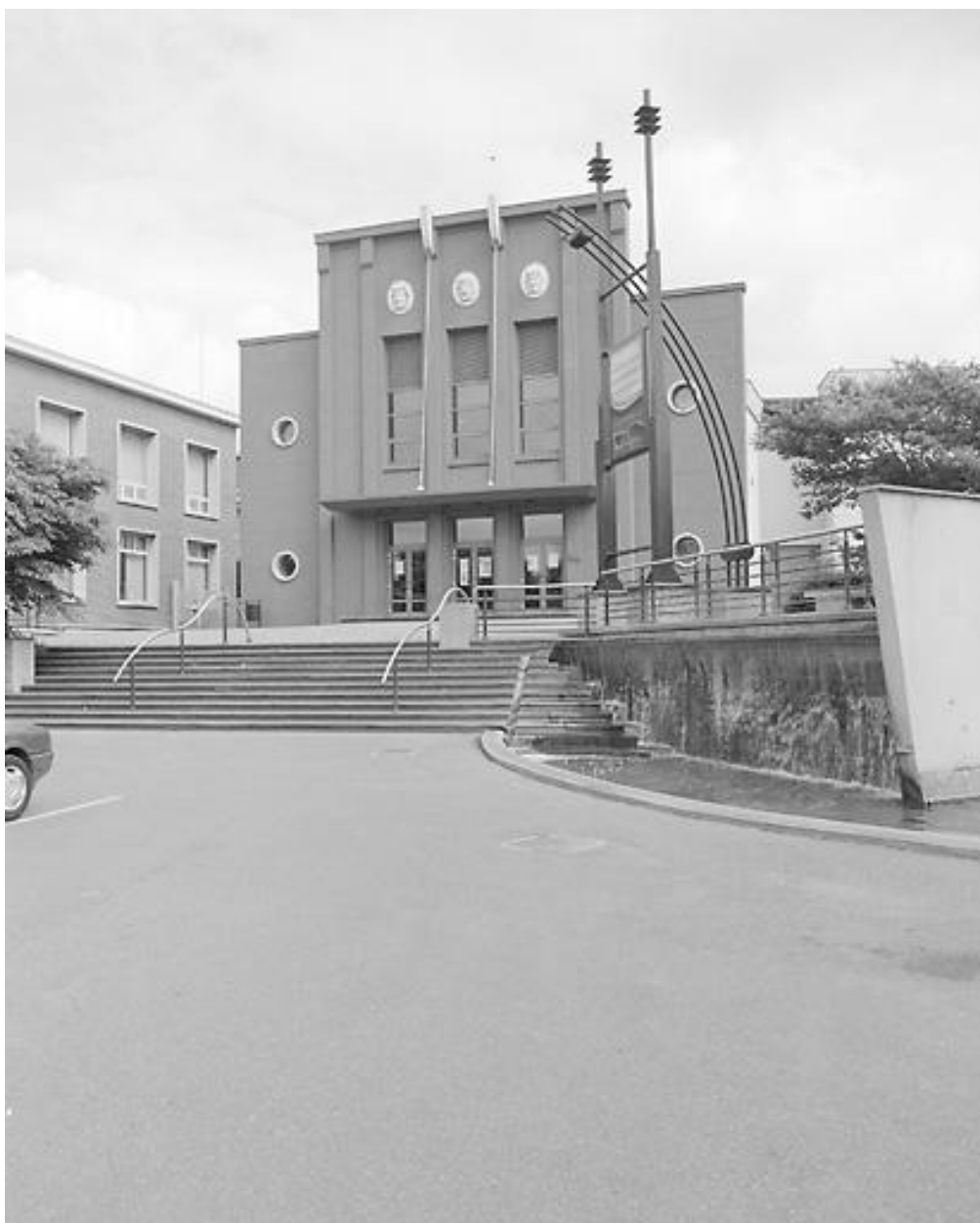
Salle des fêtes construite en 1954.
