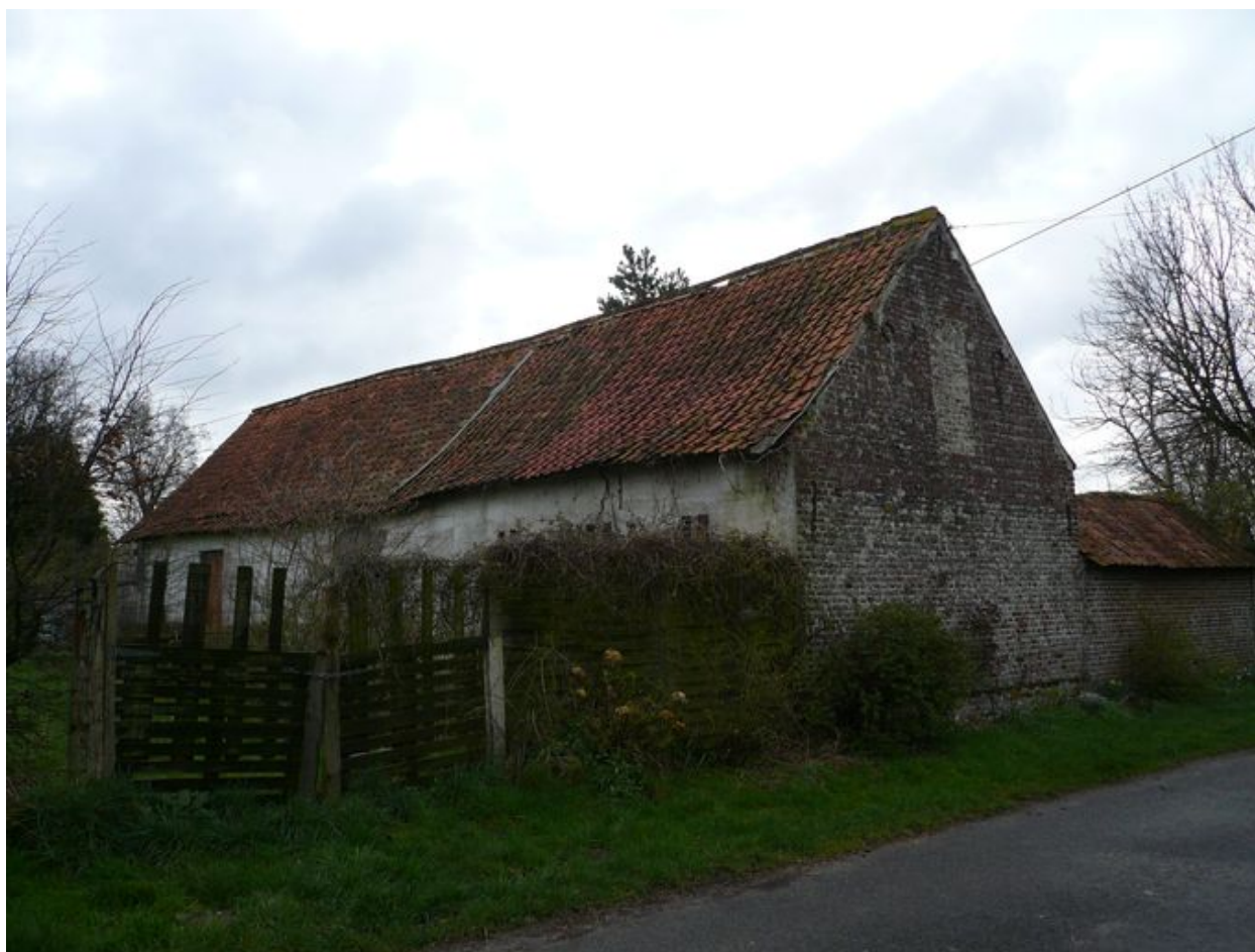
Vue postérieure des étables depuis la pâture.
