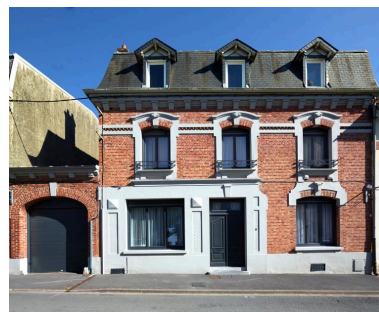
Vue générale de la façade depuis la place Faidherbe. Phot. Hubert Bouvet IVR32_20196200470NUC4A
