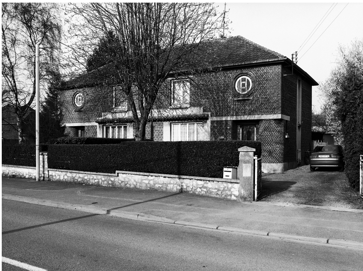
Vue générale du module (35-33 rue Anatole-France).
