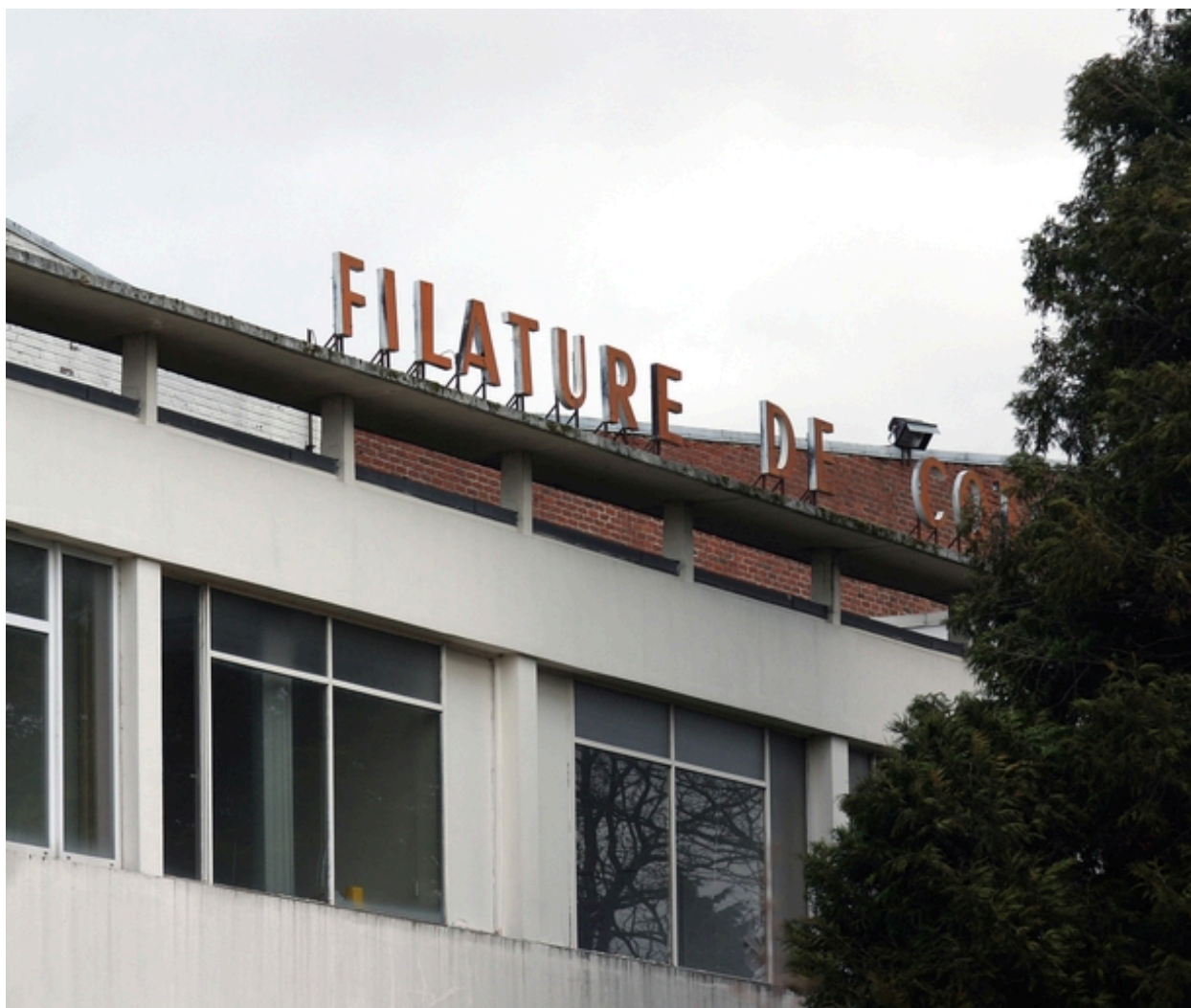
La façade des bureaux : détail.
