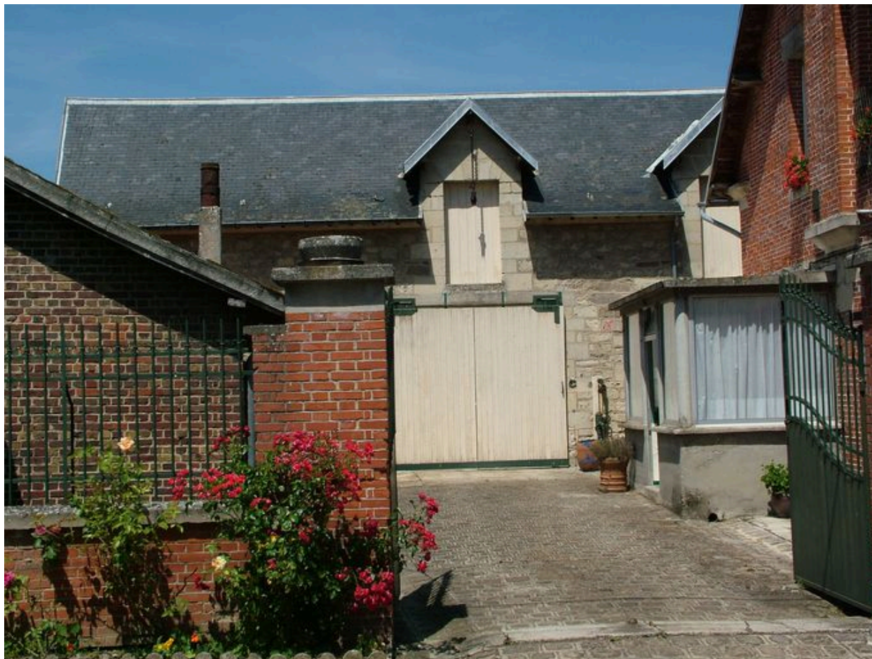
Vue de la grange.
