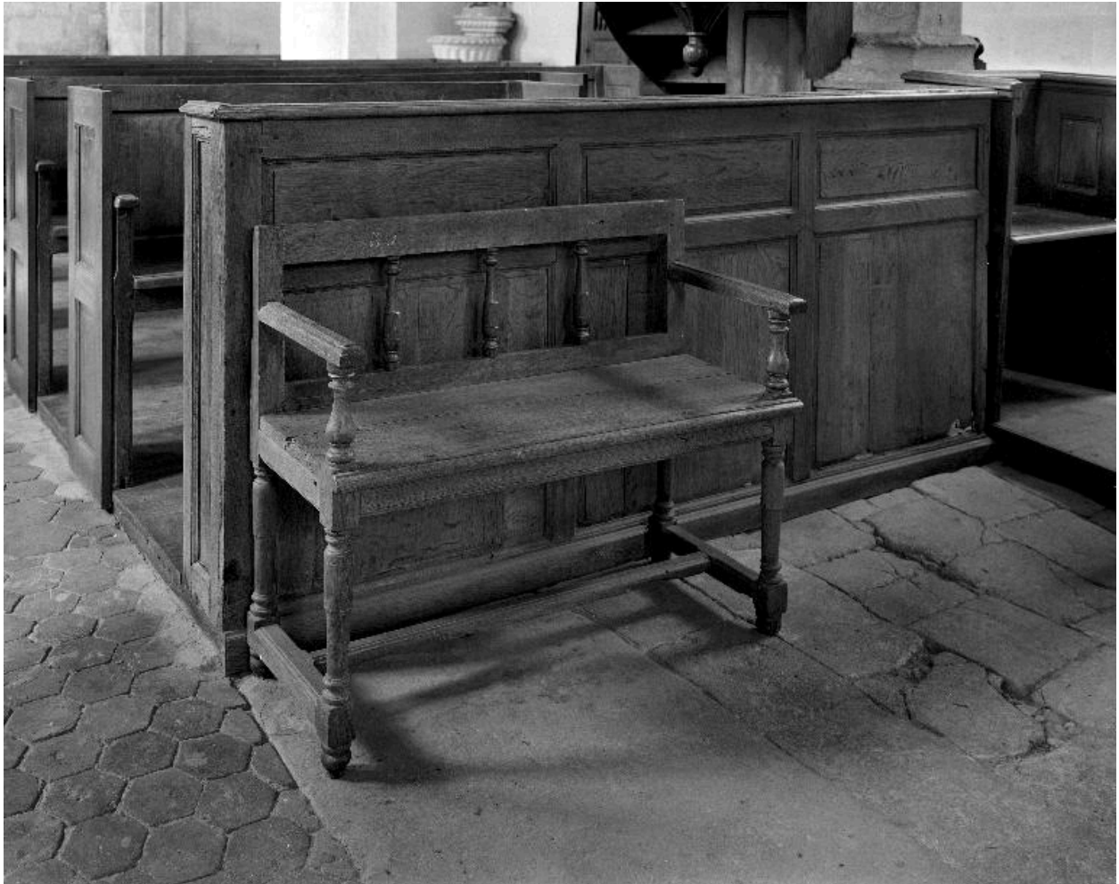
Vue générale de l'un des deux bancs.
