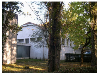
Ancienne salle des lavabos, façade est, vue depuis le sud-est. Phot. Isabelle Barbedor IVR22_20048010500NUCA
