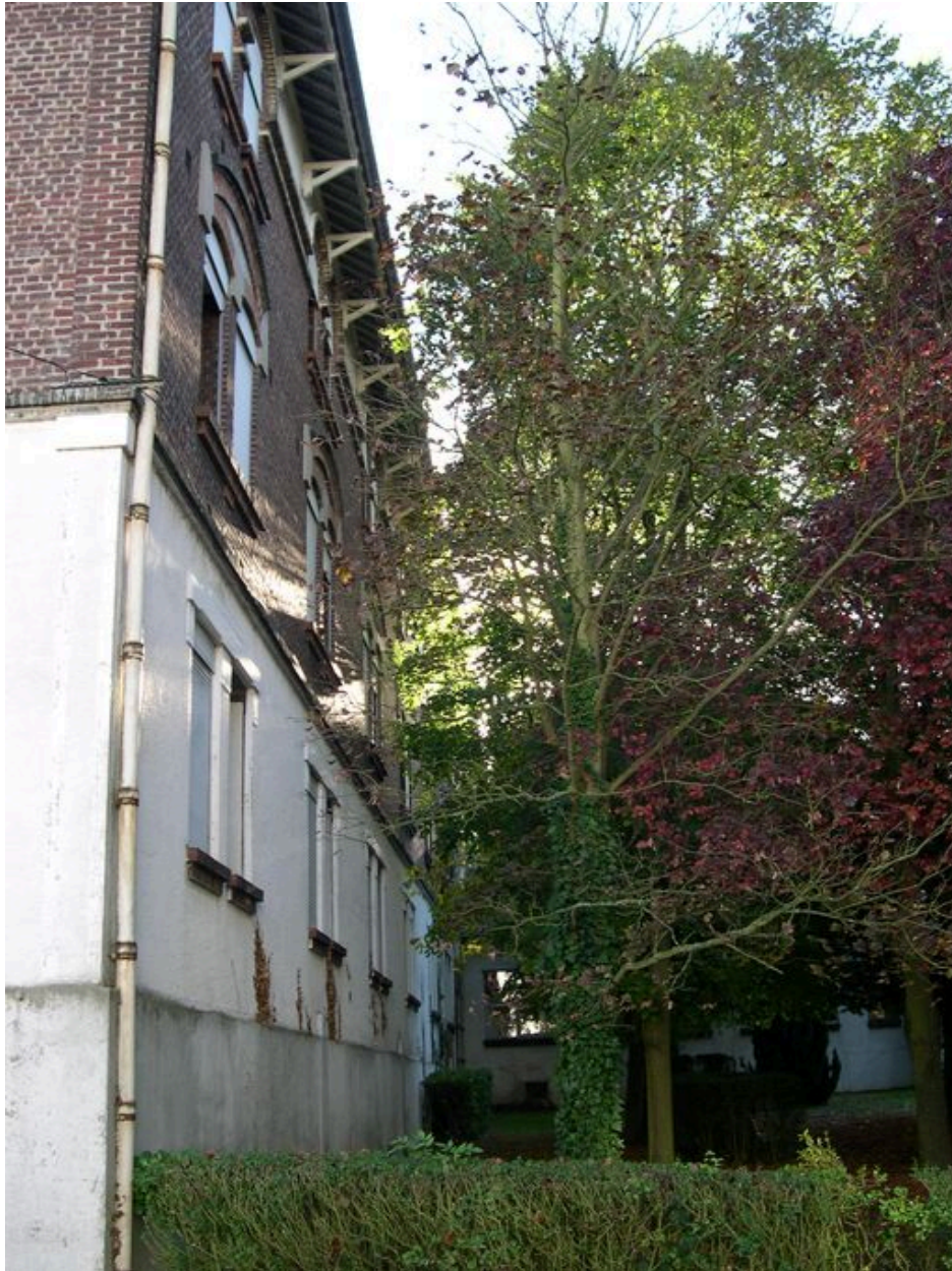
Façade sud, vue depuis le sud-est.
