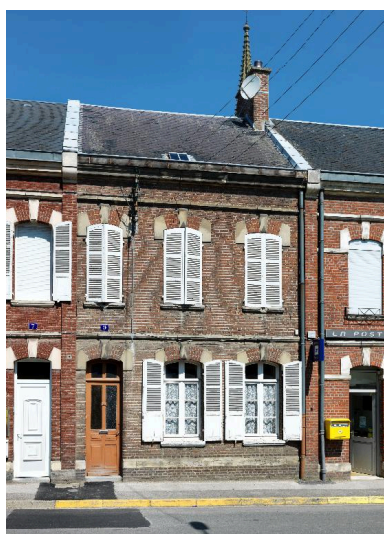
Elévation sur rue de la maison située au 9 rue Charles Cagny. Phot. Thierry Lefébure IVR22_20138000172NUC2A
