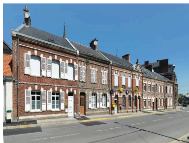
Vue d'ensemble de la façade sur rue, vers l'est. Phot. Thierry Lefébure IVR22_20138000174NUC2AQ
