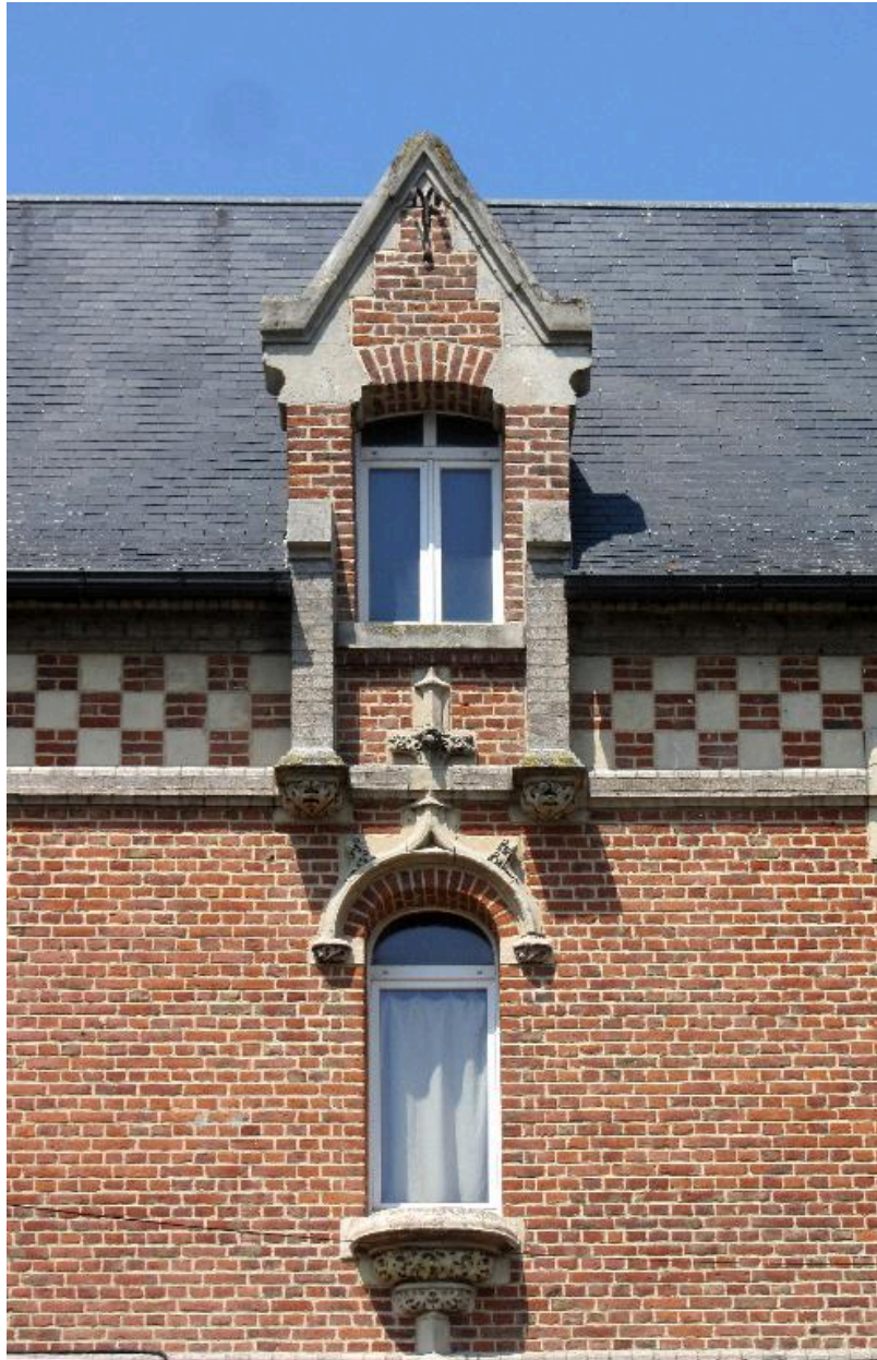
Détail du décor néo-gothique de la façade sur rue.
