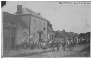
Allonville. Route de Cardonnette, 1er quart 20e siècle (AD Somme ; collection particulière). Phot. Archives départementales de la Somme IVR22_20068010281NUCA
