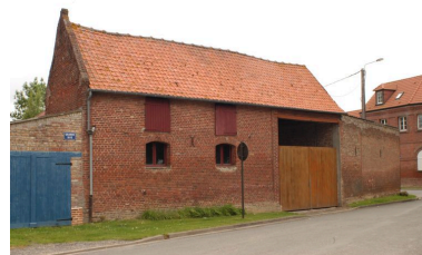
Vue depuis la Grand-Rue. Phot. Thierry Lefébure IVR22_20038000461NUCA
