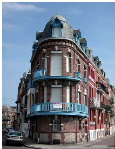
Vue d'ensemble sur l'angle. Phot. Elisabeth Justome IVR22_20038005380NUCA
