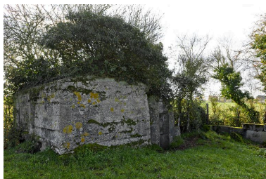
Vue de trois-quarts, vers le sud-ouest Phot. Jean-Marc Ramette IVR31_20145904887NUCA
