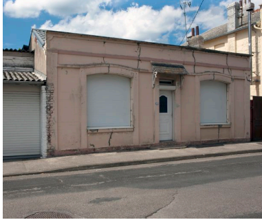
Vue générale. Phot. Pierre Thibaut IVR31_20146202199NUCA
