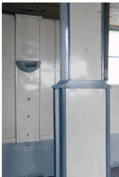
Détail d'un pilier de la nef. Phot. Pierre Thibaut IVR31_20155900753NUCA
