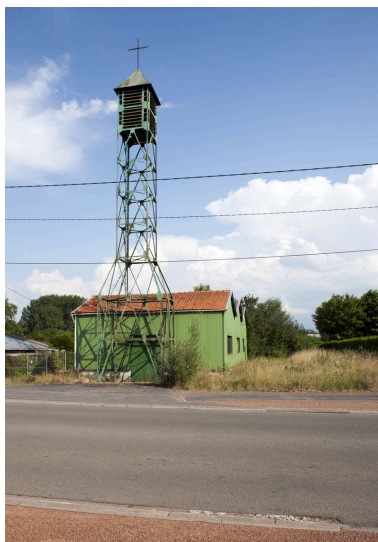
Vue de l'entrée de la chapelle. Phot. Pierre Thibaut IVR31_20155900759NUCA
