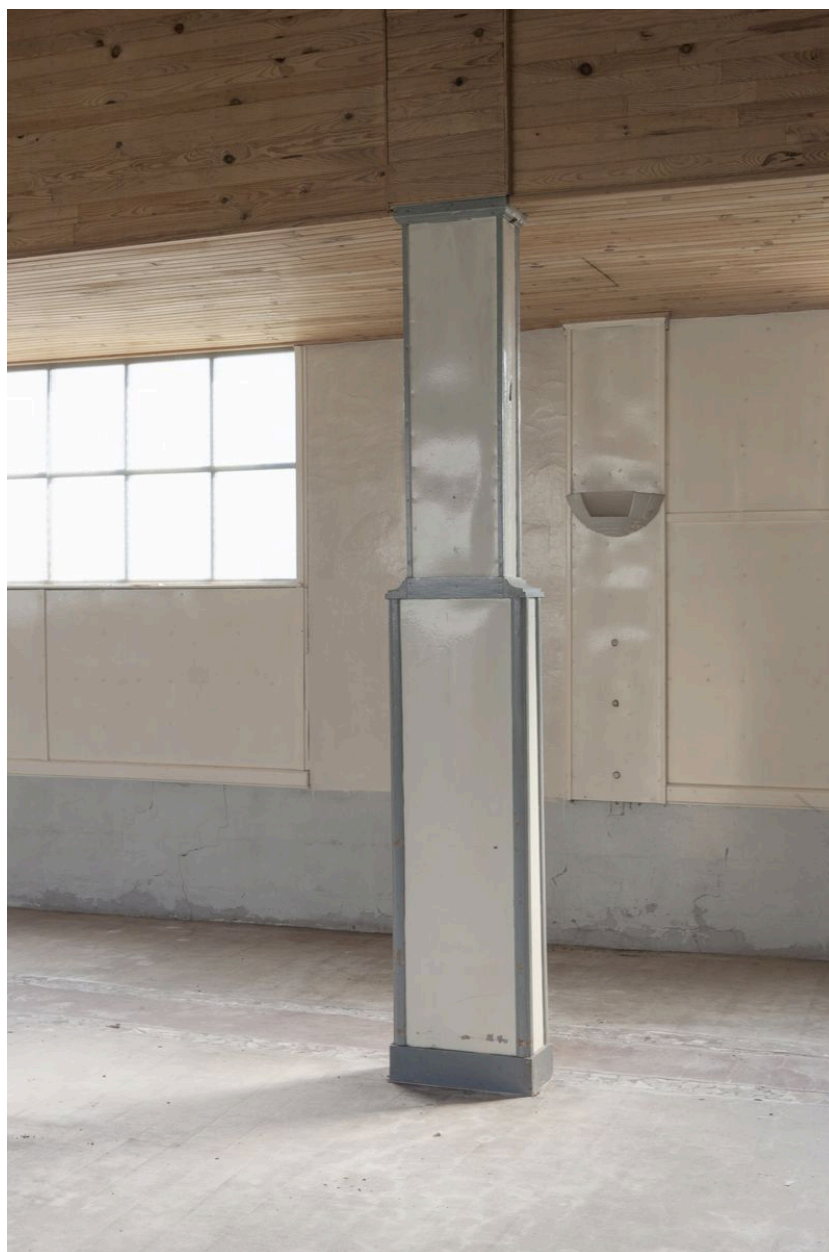
Vue générale d'un pilier de la nef.
