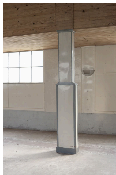
Vue générale d'un pilier de la nef. Phot. Pierre Thibaut IVR31_20155900754NUCA
