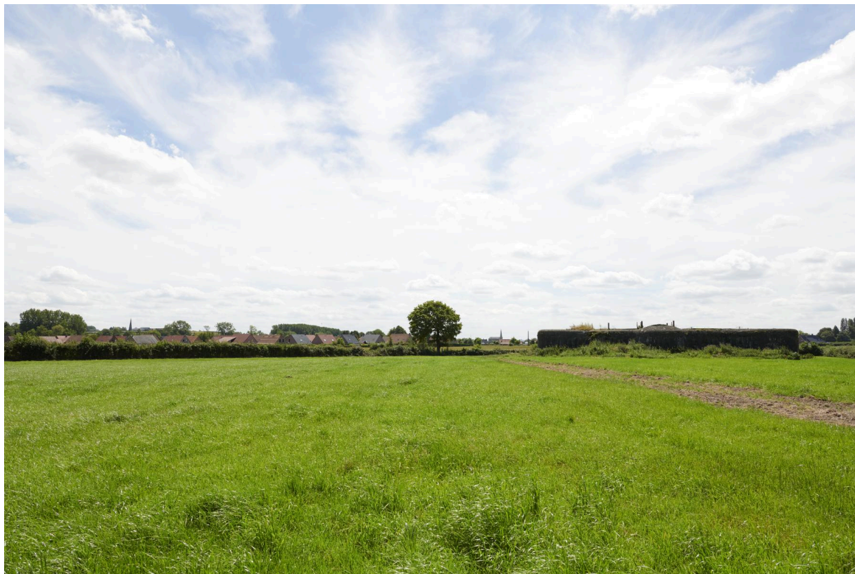
Vue de la casemate depuis le nord.
