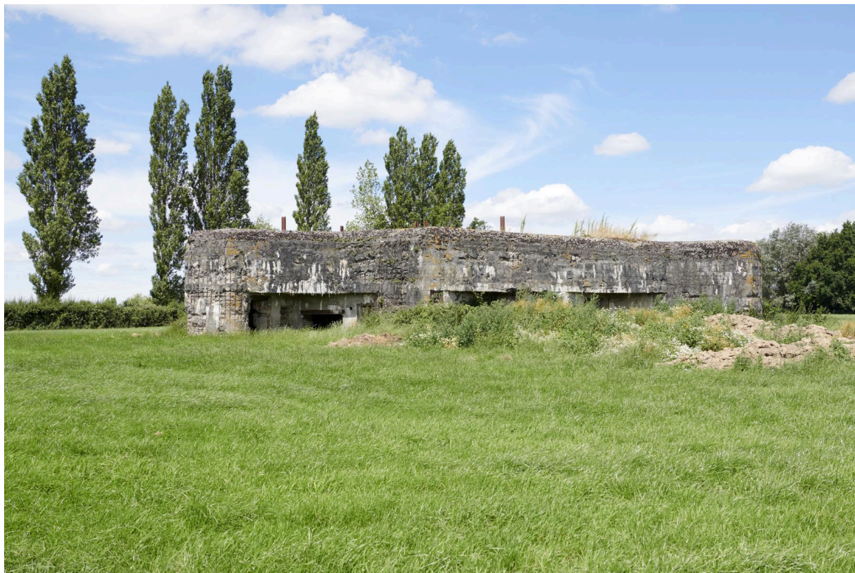
Vue de la partie sud de la casemate.
