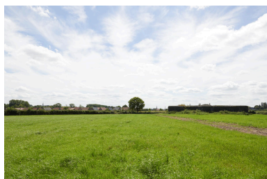
Vue de la casemate depuis le nord. Phot. Delphine Volto-Jourdan IVR32_20245902604NUCA
