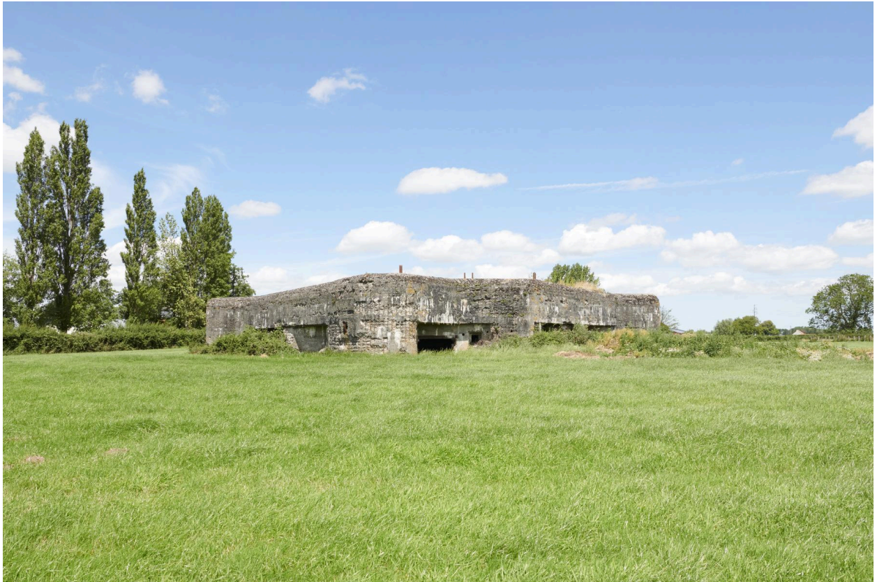
Vue du sud-est de la casemate.
