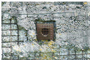
Détail d'une goulotte à grenade. Phot. Delphine Volto-Jourdan IVR32_20245902610NUCA
