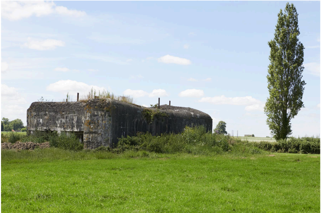
Vue de la partie est de la casemate.
