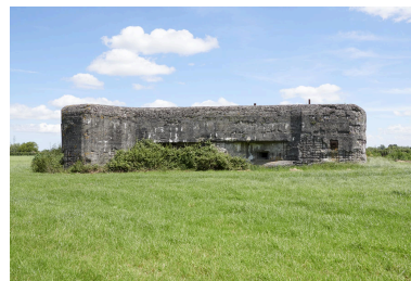
Vue de l'ouest de la casemate. Phot. Delphine Volto-Jourdan IVR32_20245902609NUCA
