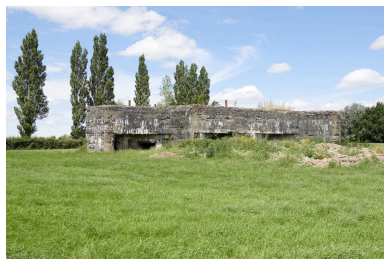
Vue de la partie sud de la casemate. Phot. Delphine Volto-Jourdan IVR32_20245902607NUCA
