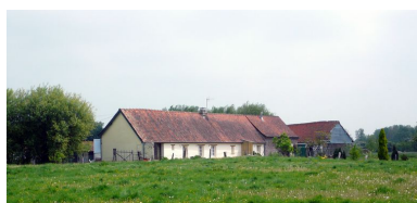
Vue générale postérieure. Phot. Inès Guérin IVR22_20078005057NUCA
