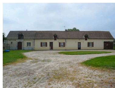
Vue du logis depuis la cour. Phot. Inès Guérin IVR22_20078005059NUCA
