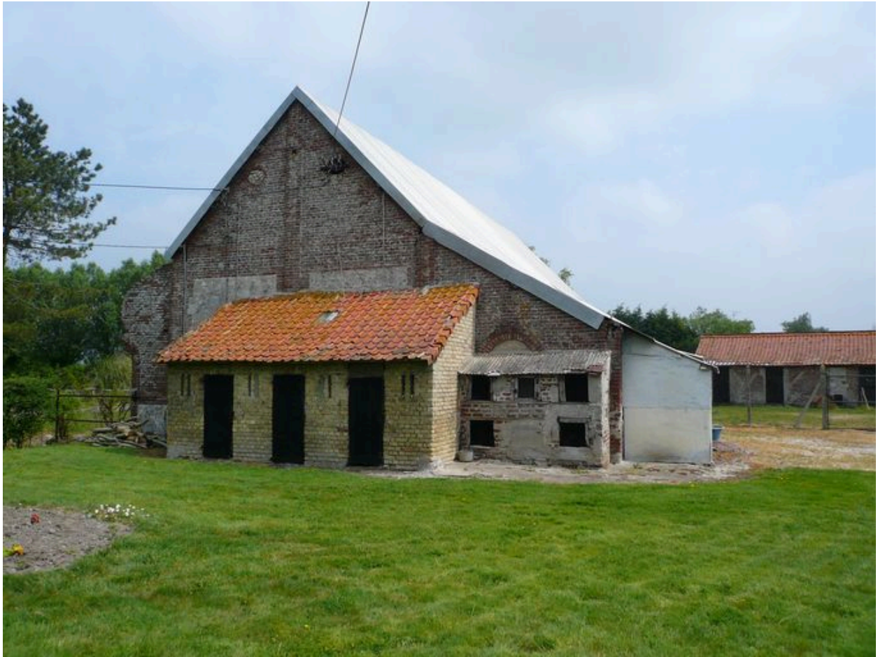
Vue latérale de la grange.
