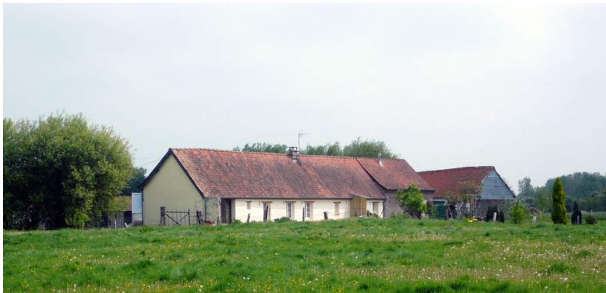
Vue générale postérieure.
