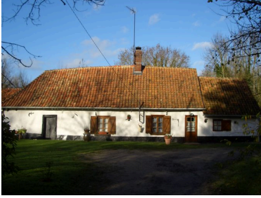
Vue générale. Phot. Inès Guérin IVR22_20068005616NUCA
