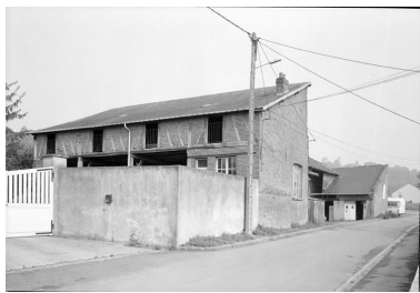
Ancien atelier de fabrication. Vue générale. Phot. Jean-Michel Perrin IVR22_19846000989X
