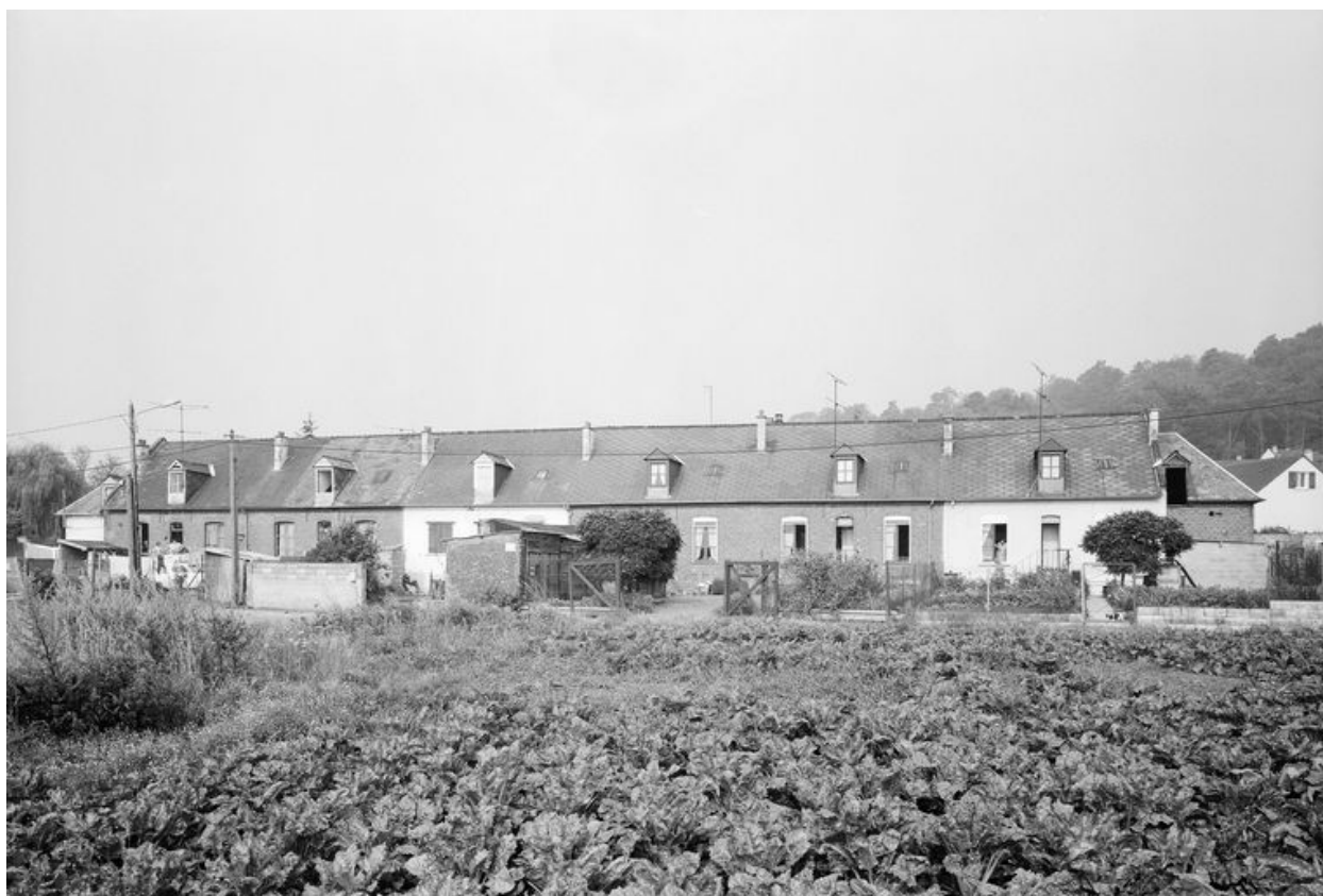
Maisons ouvrières de l'usine de chaussures, rue de la Fosse-Louvière.
