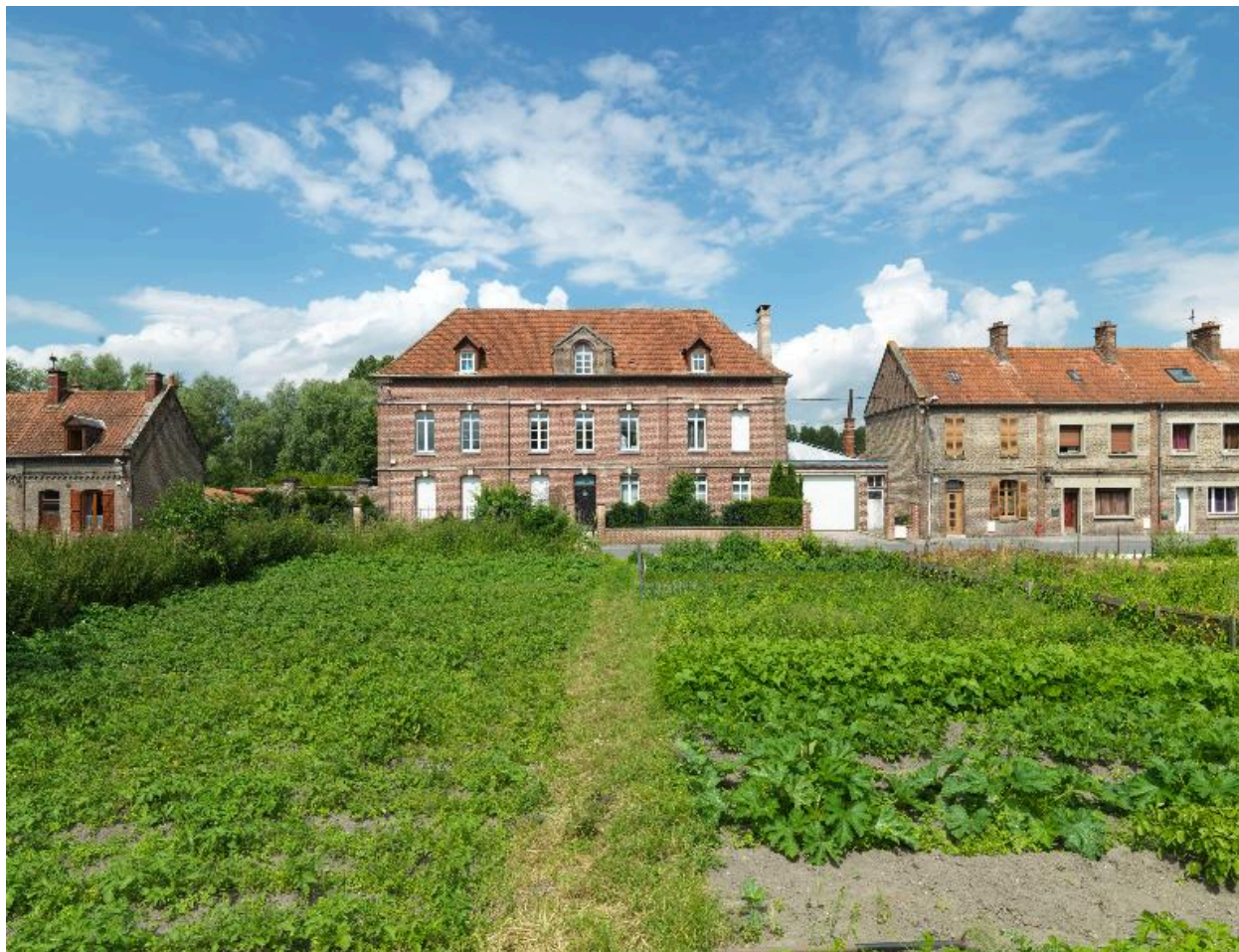
Vue d'ensemble sur rue de la crèche des Moulins-Bleus au milieu des logements.
