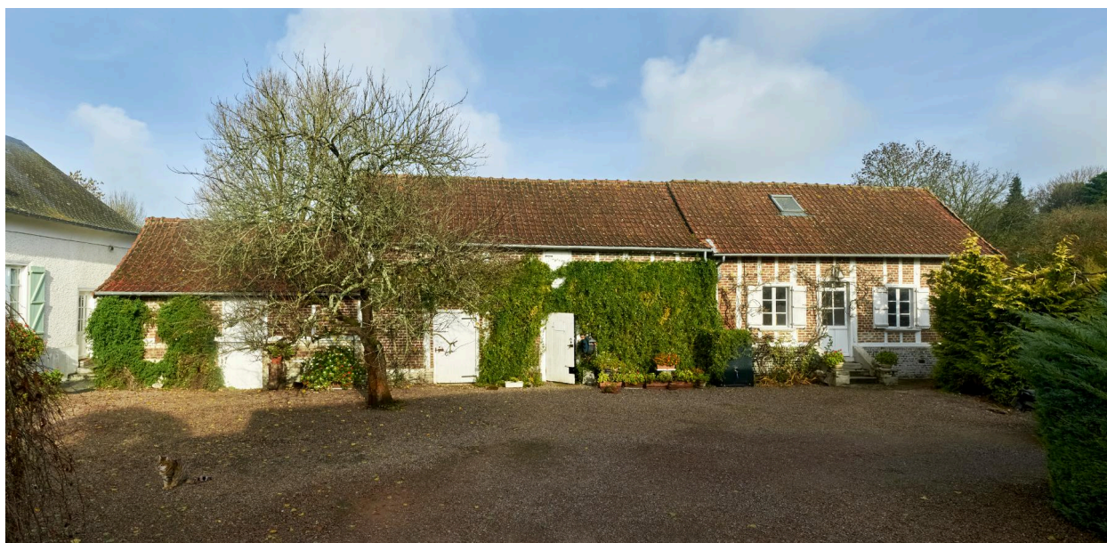
Bâtiments nord, depuis la cour.
