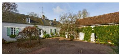
Bâtiments et cour, depuis le sud-est. Phot. Thierry Lefébure IVR32_20238000694NUCA
