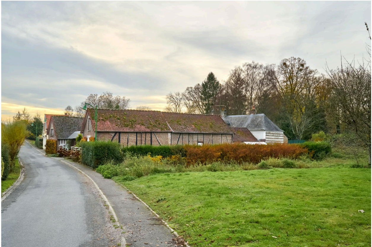
Vue générale, depuis le nord.
