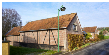
Bâtiment sud. Phot. Thierry Lefébure IVR32_20238000689NUCA
