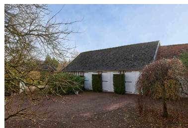
Garages sud, depuis la cour. Phot. Thierry Lefébure IVR32_20238000696NUCA
