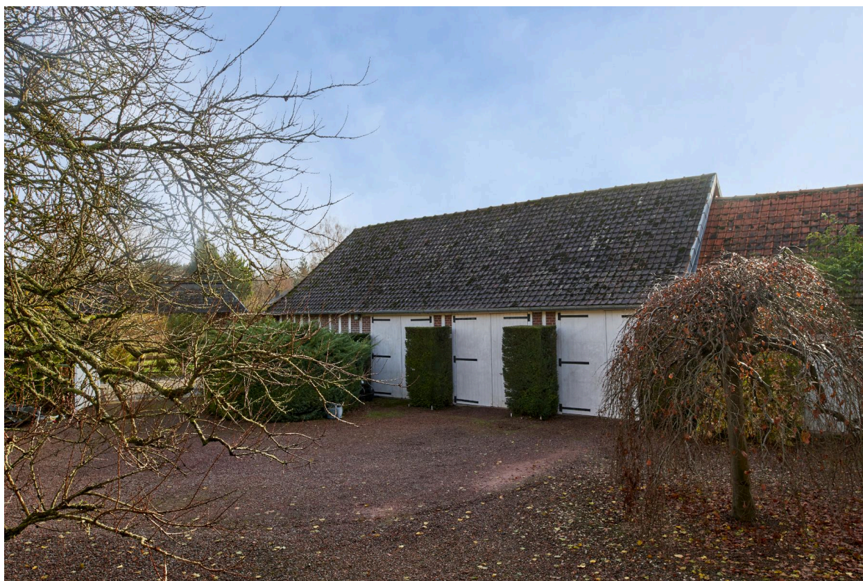
Garages sud, depuis la cour.
