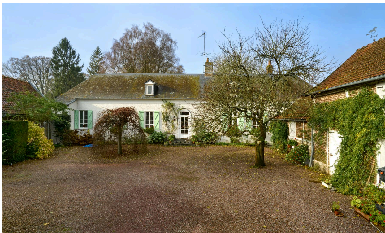
Maison et cour, depuis l'est.
