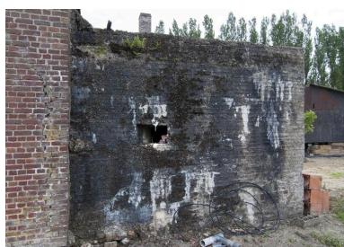
Casemate B, vers le sud-ouest Phot. Jean-Marc Ramette
