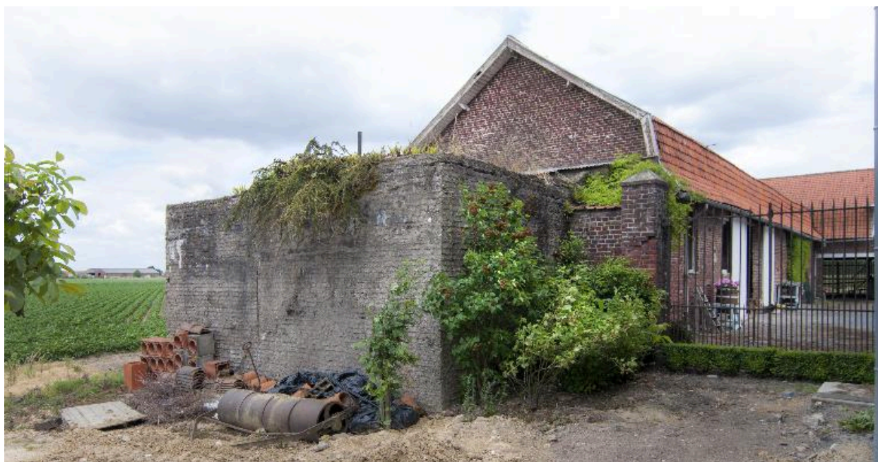
Casemate B, vue de trois-quarts vers 3 sud-est
