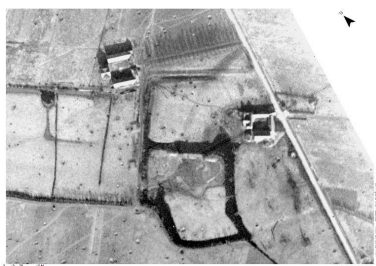
Ferme de la Hutte une photographies aérienne britannique du 6 mars 1918. Le colombier masque encore l'observatoire. Phot. Jean-Marc Ramette IVR32_20175901515NUCA
