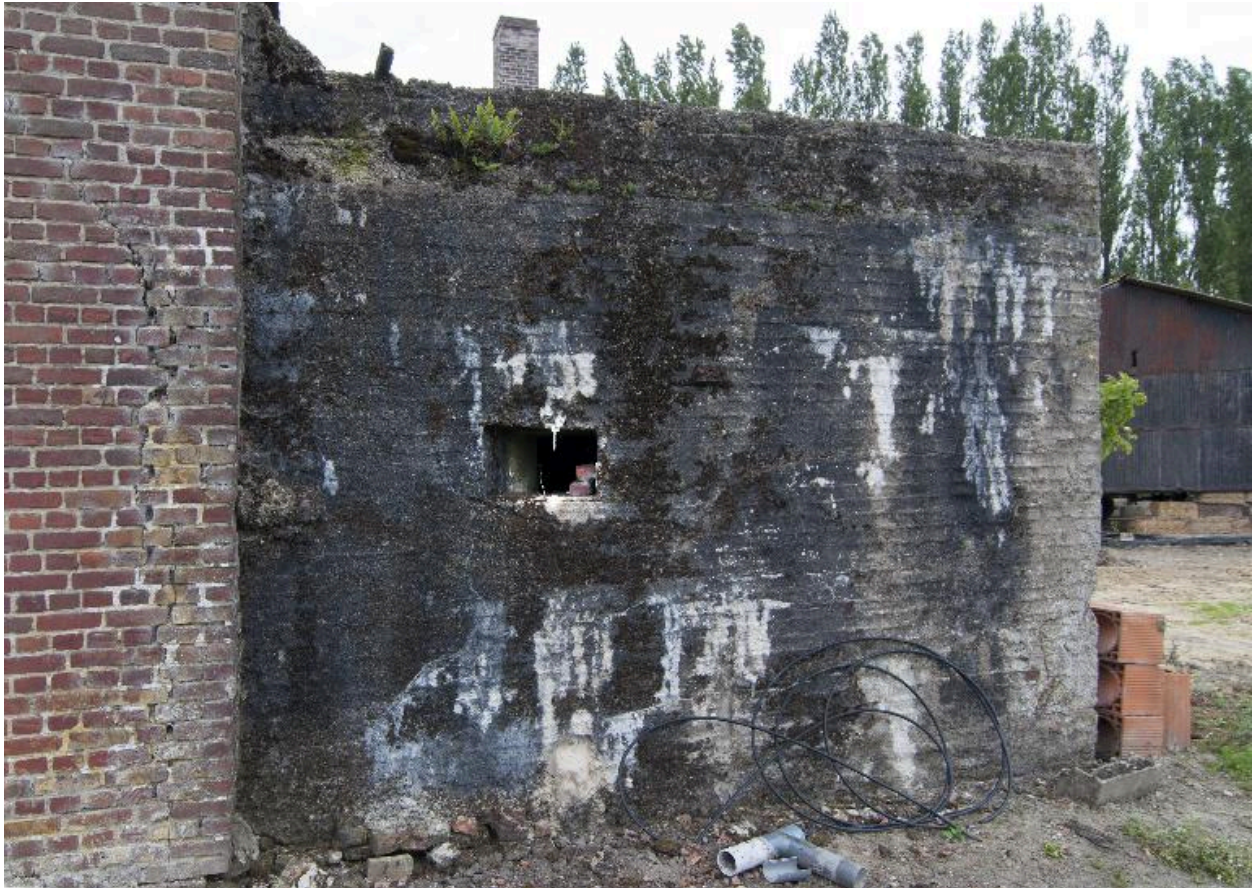
Casemate B, vers le sud-ouest
