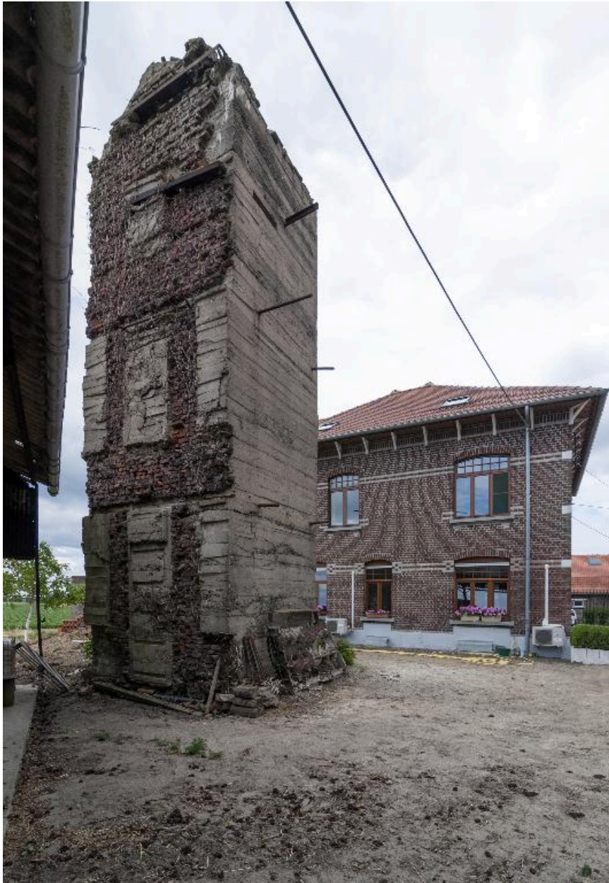
Vue de trois-quarts vers l'est de l'observatoire casematé (A). On remarque l'empreinte des ouvertures de l'ancien colombier ainsi que l'embrasure d'observation au sommet.
