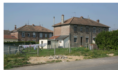
Pavillons construits en 1923. Phot. Frédéric Pillet IVR22_20070205156NUCA
