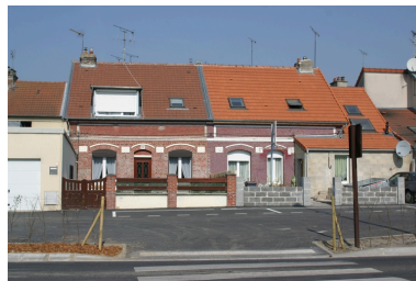
Façade d'un pavillon de la cité Dambrun. Phot. Frédéric Pillet IVR22_20070205152NUCA
