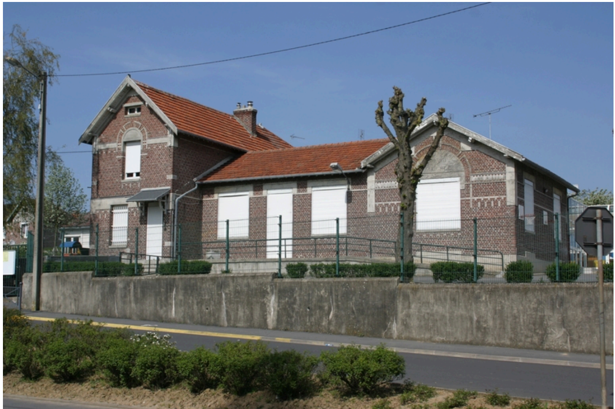
Façade antérieure de la pouponnière.
