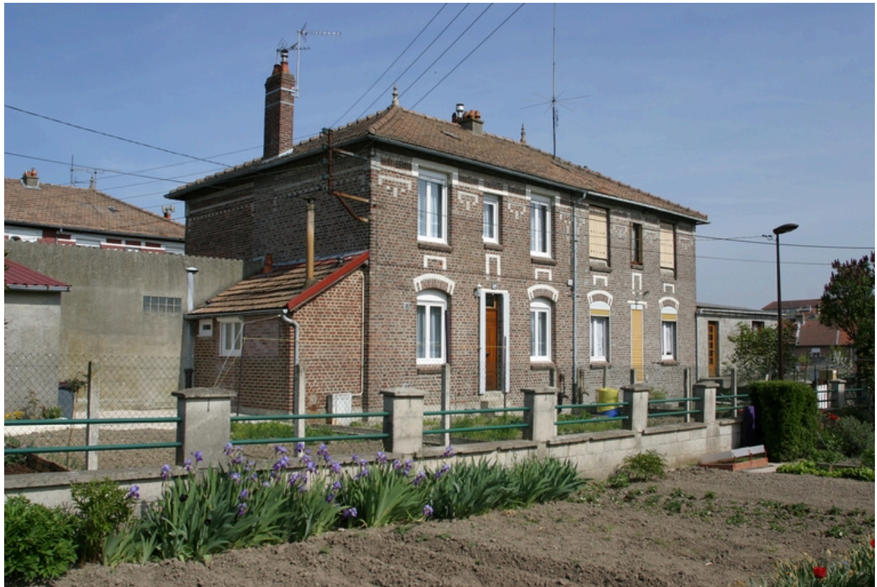
Façade d'un pavillon de 1923.
