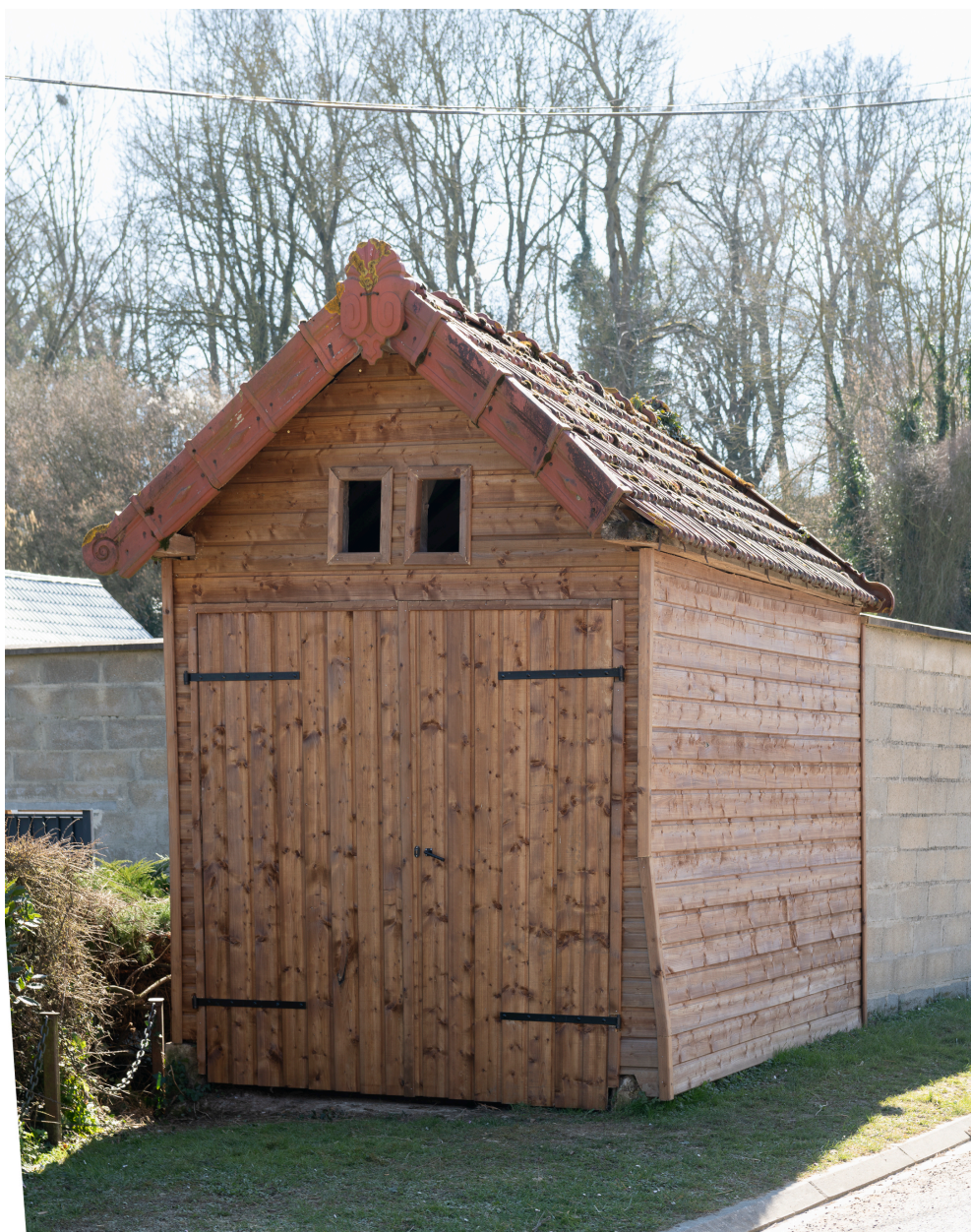
Remise de matériel d'incendie, rue la Ruelle, vue depuis le nord.
