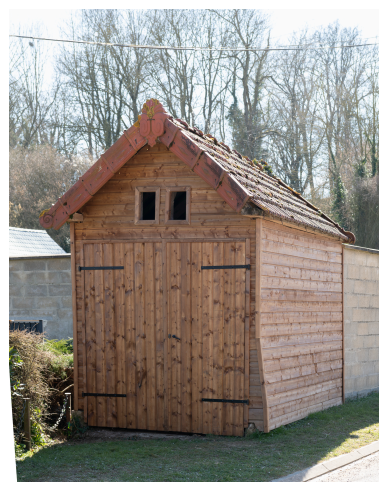
Remise de matériel d'incendie, rue la Ruellette, vue depuis le nord. Phot. Marc Kérignard IVR32_20256000092NUCA
