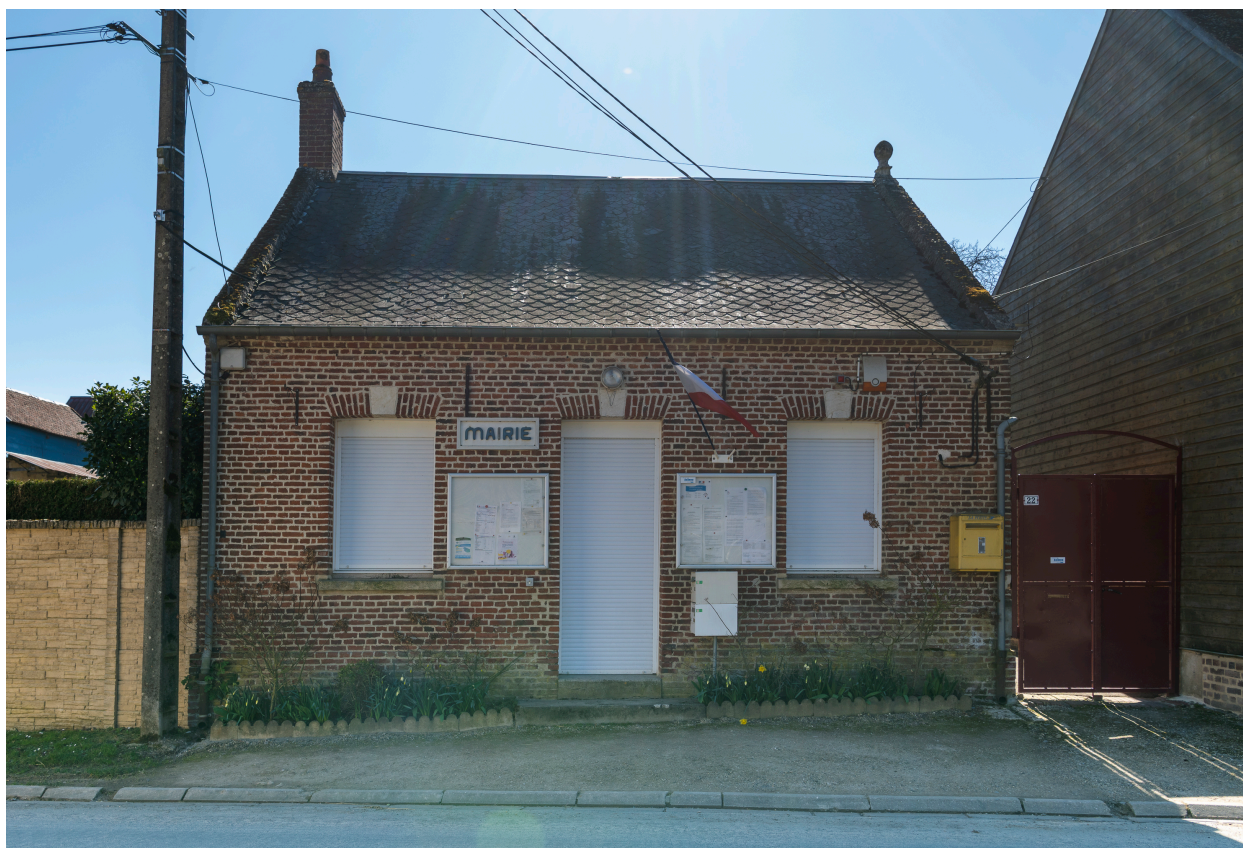
Ancienne école, aujourd'hui mairie, n°22 de la rue Principale, vue depuis le nord.
