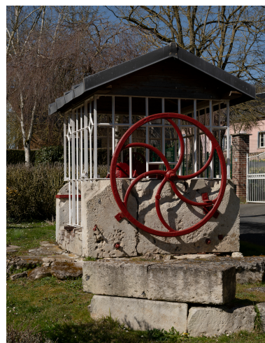
Puits de la Place avec pompe Dragor, vue depuis l'est. Phot. Marc Kérignard IVR32_20256000082NUCA
