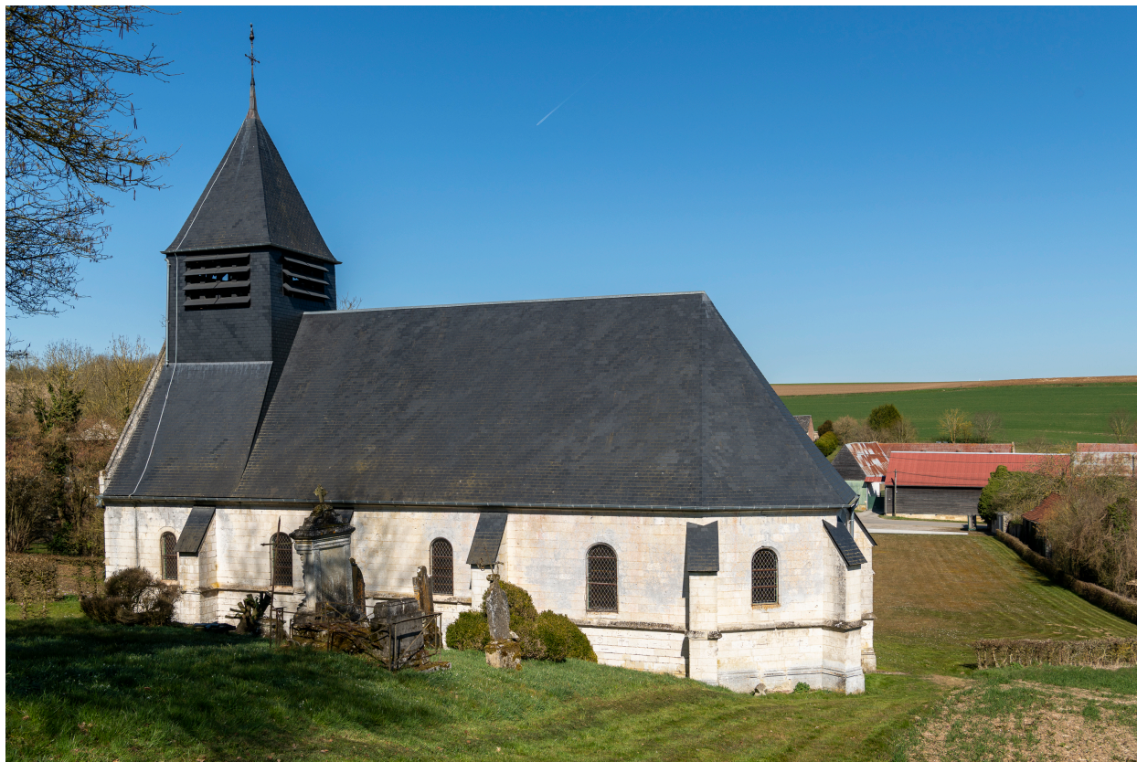
Vue générale de l'église depuis le sud-est.
