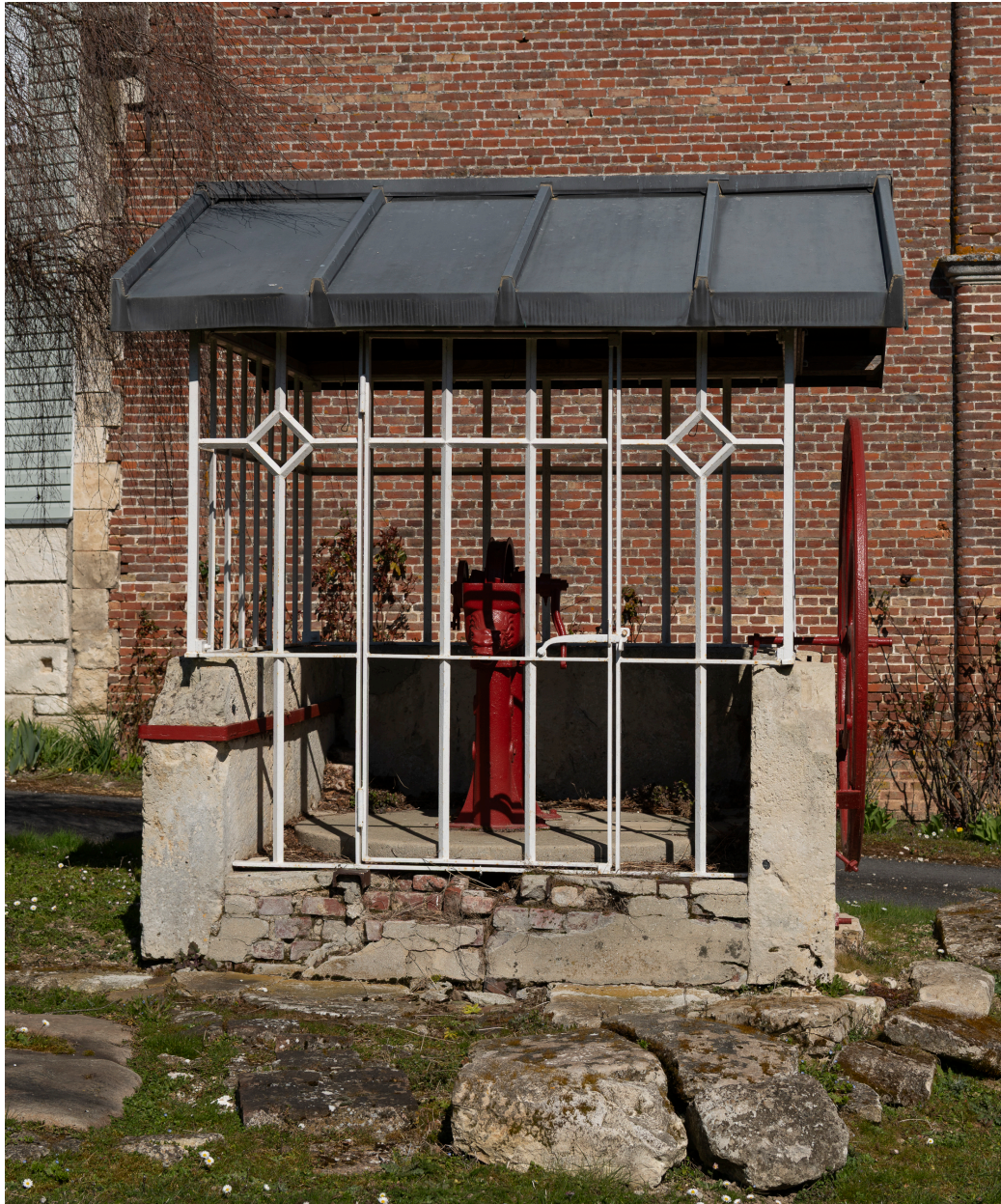
Puits de la Place avec pompe Dragor, vue depuis le sud.
