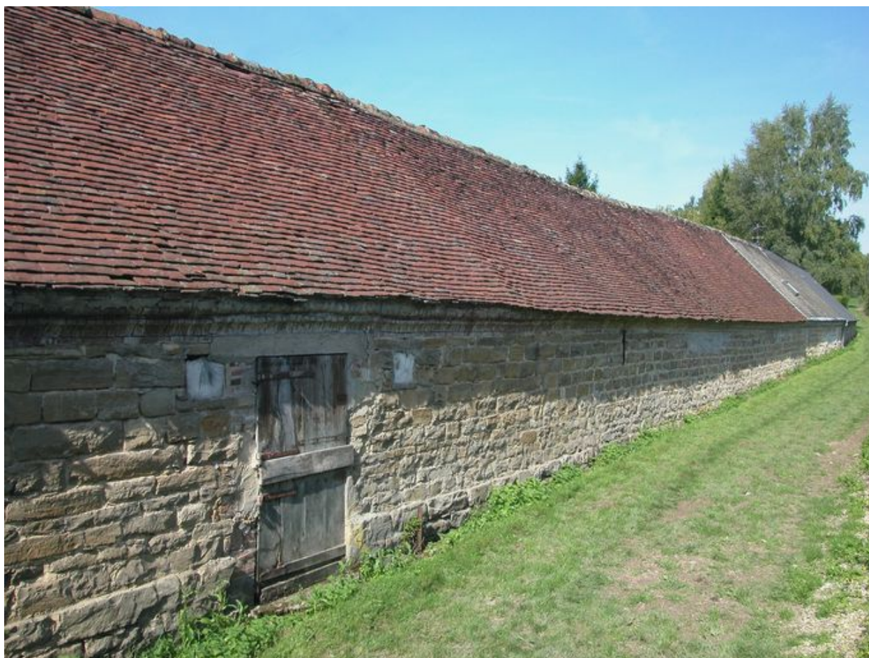
Façade extérieure des dépendances agricoles du moulin.
