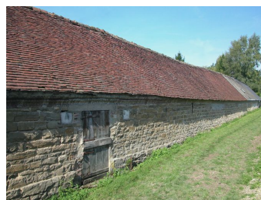
Façade extérieure des dépendances agricoles du moulin.
