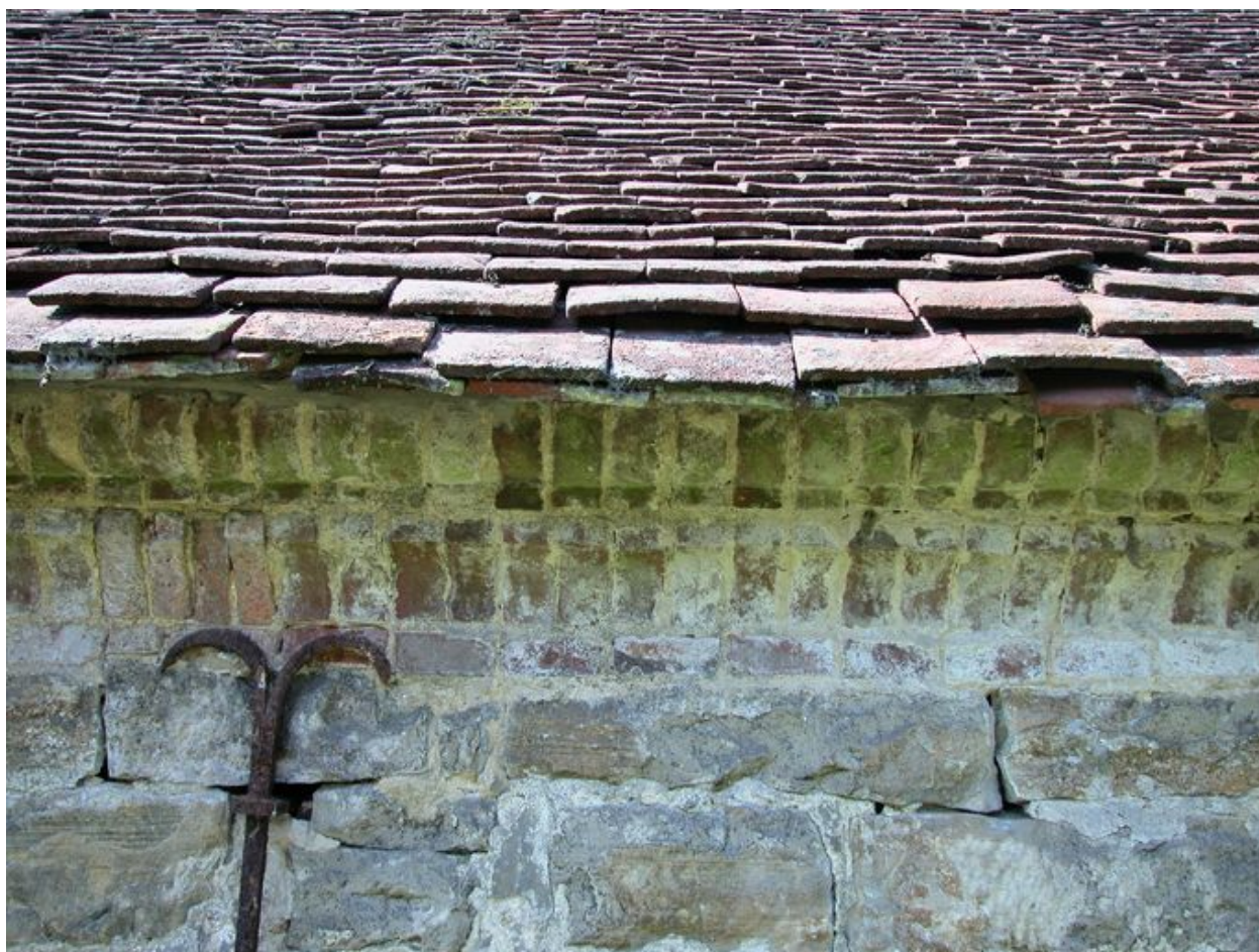
Détail de la corniche moulurée.
