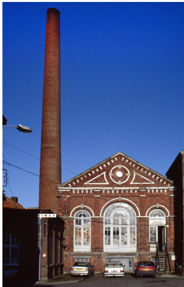
Salle des machines de la filature Mahieu à Houplines Phot. Olivier Marlard IVR31_19965901549ZA
