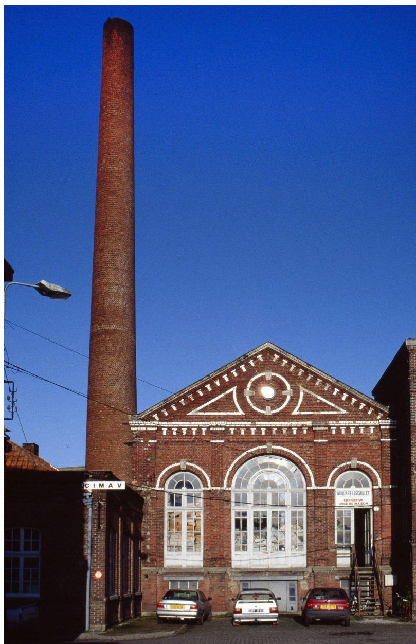
Salle des machines de la filature Mahieu à Houplines
