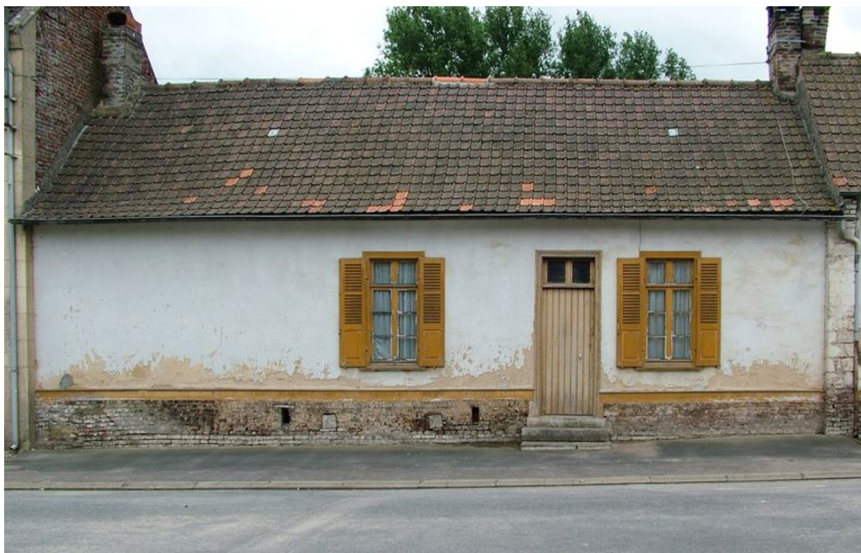
Façade du logis sur rue.
