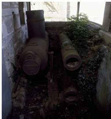
Chaudière tubulaire à deux bouilleurs. Phot. Thierry Lefébure IVR22_20006000645XA
