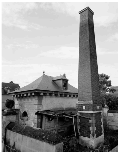
Façade postérieure : vue d'ensemble avec le bâtiment des chaudières et la cheminée. Phot. Thierry Lefébure IVR22_20006000569V
