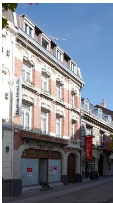
Vue générale. Phot. Pierre Thibaut IVR31_20086200165NUCA
