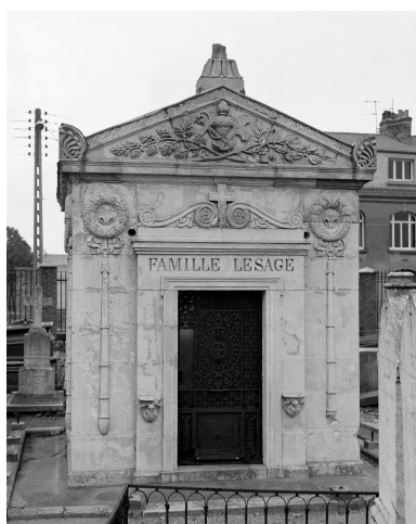
Façade : entrée. Phot. Philippe Caudroit IVR31_19816203292X
