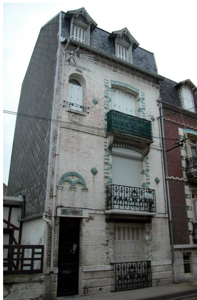
Vue d'ensem. depuis la rue. Phot. Elisabeth Justome IVR22_20058002517NUCA
