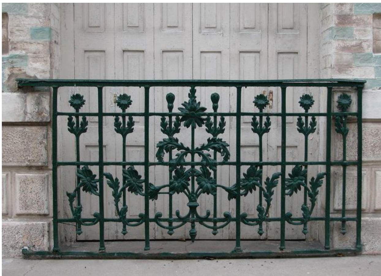
Vue du garde-corps en fonte de la baie du rez-de-chaussée.
