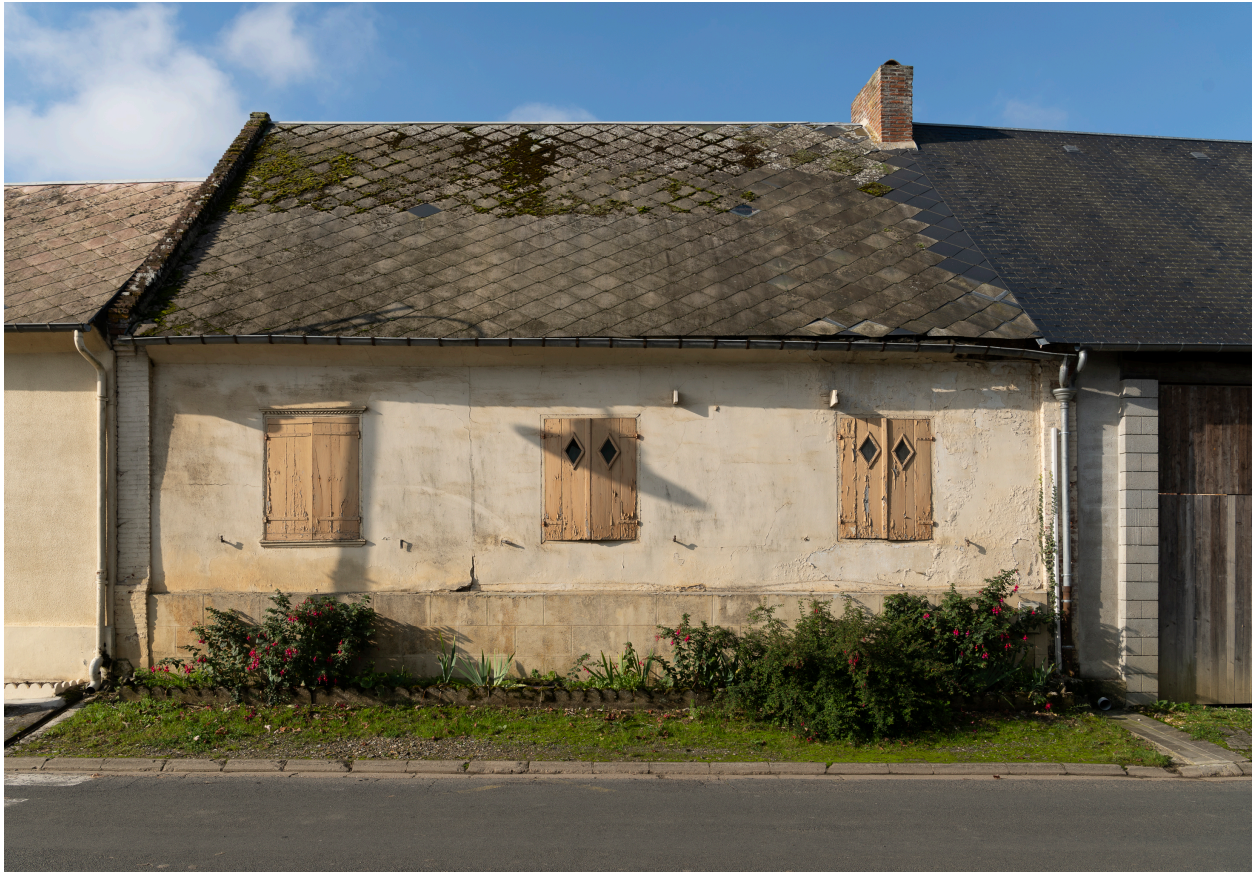
Logis sur rue au n°4 de la place de Beauvoir, vue depuis l'est.
