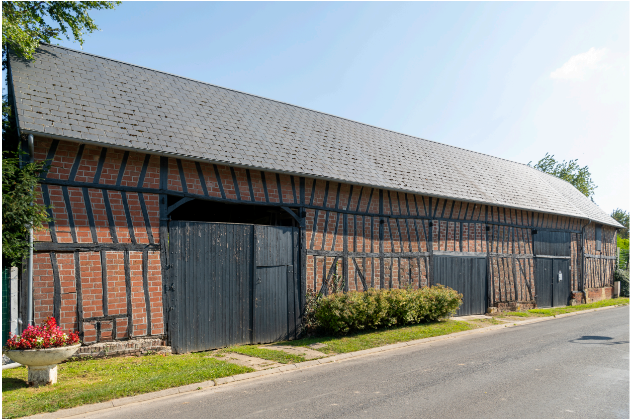
Grange, entrée charretière et bâtiments agricoles sur la rue, n°9 de la rue de la Folie, vue depuis l'ouest.
