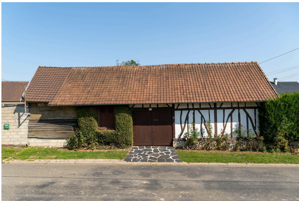
Grange sur rue avec porte à engranger, n°9 de la rue de Bonvillers, vue depuis l'ouest.
