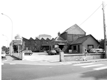
Vue antérieure de l'atelier de fabrication avec sheds. Phot. Laurent Jumel IVR22_19966002556X
