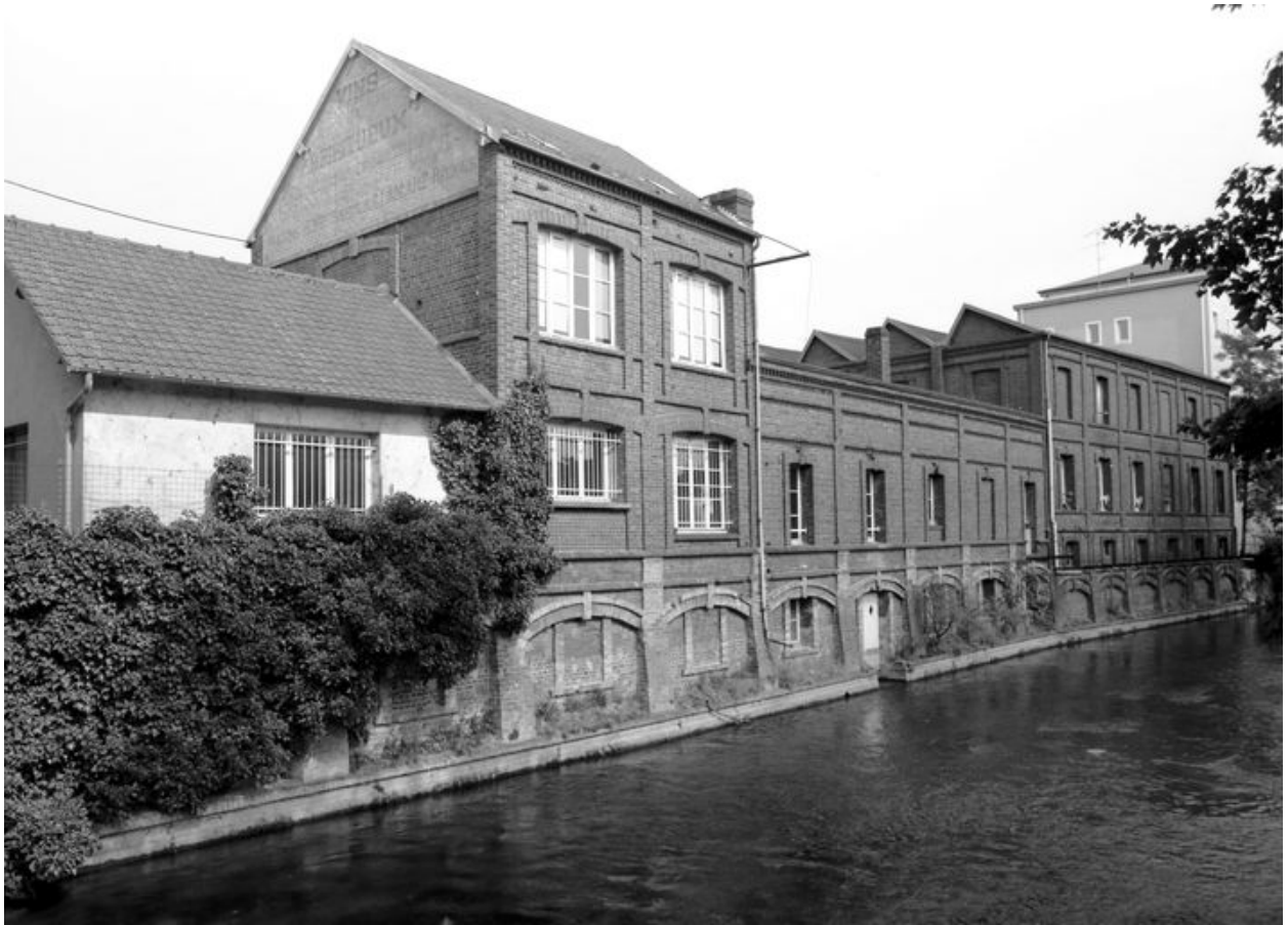
Vue latérale sud de l'usine.
