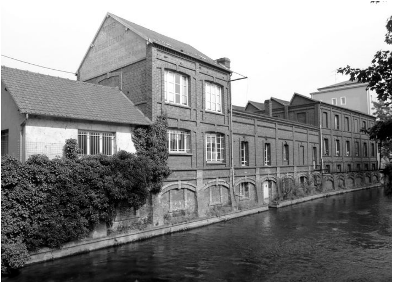
Vue latérale sud de l'usine.
