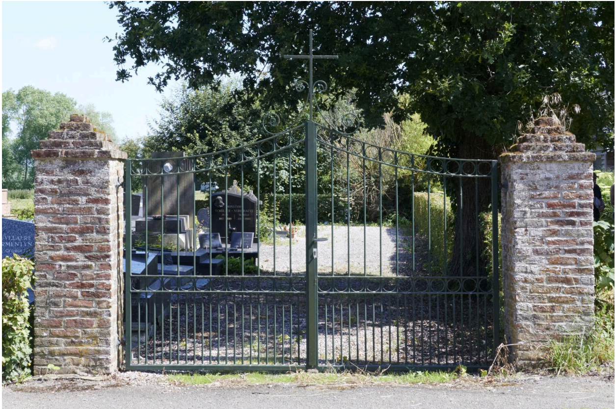
Portail d'accès situé rue Principale et donnant accès à l'est du cimetière.
