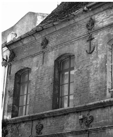
Maison n° 10, vue partielle : étage carré, modénature, ancrage (état en 2001). Phot. Pierre Thibaut IVR31_20015901339X
