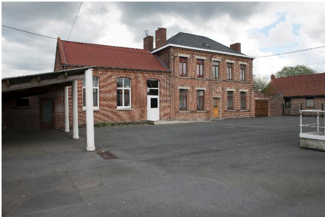
Vue générale de salle de classe et le préau.
