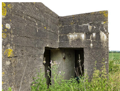
Entrées, sud Phot. Jean-Marc Ramette IVR31_20145904475NUCA
