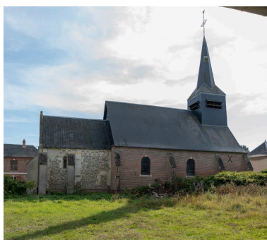
Vue depuis le nord. Phot. Marc Kérignard IVR32_20216000933NUCA
