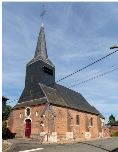
Vue générale depuis le sud-ouest. Phot. Marc Kérignard IVR32_20216000931NUCA
