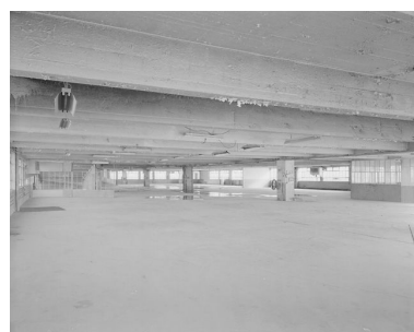
Vue d'ensemble du niveau 3. Phot. Thierry Lefébure IVR22_19988001199V
