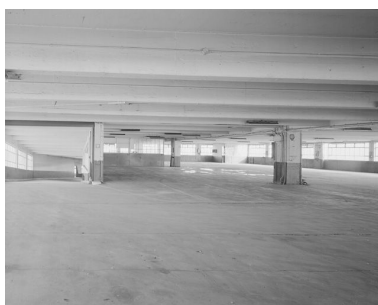
Vue d'ensemble du niveau 3. Phot. Thierry Lefébure IVR22_19988001198V
