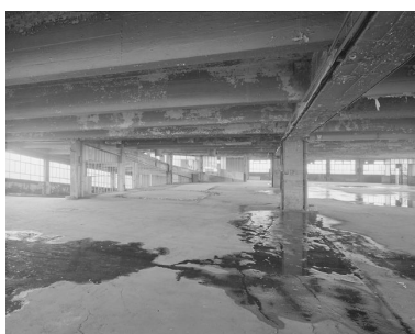
Vue d'ensemble du niveau 3. Phot. Thierry Lefébure IVR22_19988001200V
