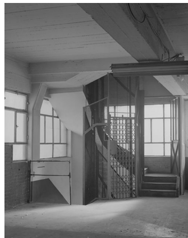
Vue d'ensemble de la cage d'ascenseur. Phot. Thierry Lefébure IVR22_19988001209X
