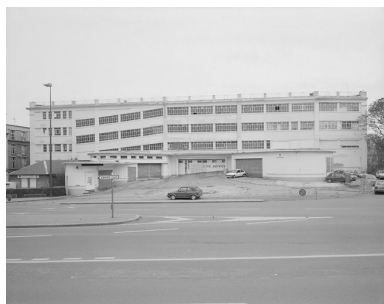
Vue générale depuis l'ouest. Phot. Thierry Lefébure IVR22_19978001085V
