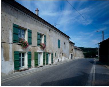
Vue générale depuis la rue. Phot. Thierry Lefébure IVR22_19930200955VA
