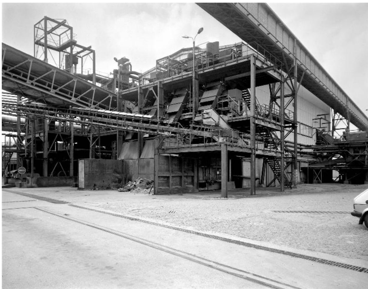
Unité de lavage.
