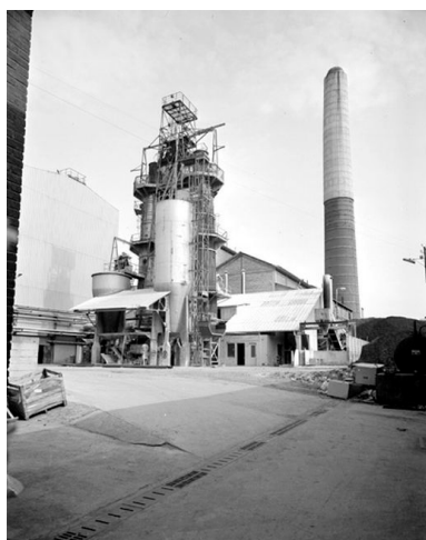
Fours à chaux. Phot. Thierry Lefébure IVR22_19888000872V
