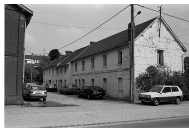
Logement d'ouvriers saisonniers. Phot. Francis Dubuc IVR22_19908000766Z
