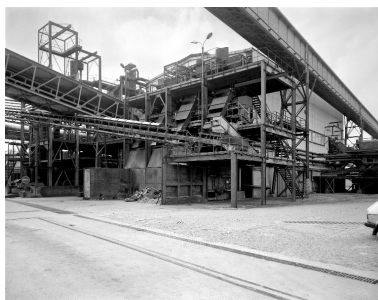
Unité de lavage. Phot. Thierry Lefébure IVR22_19888000876V
