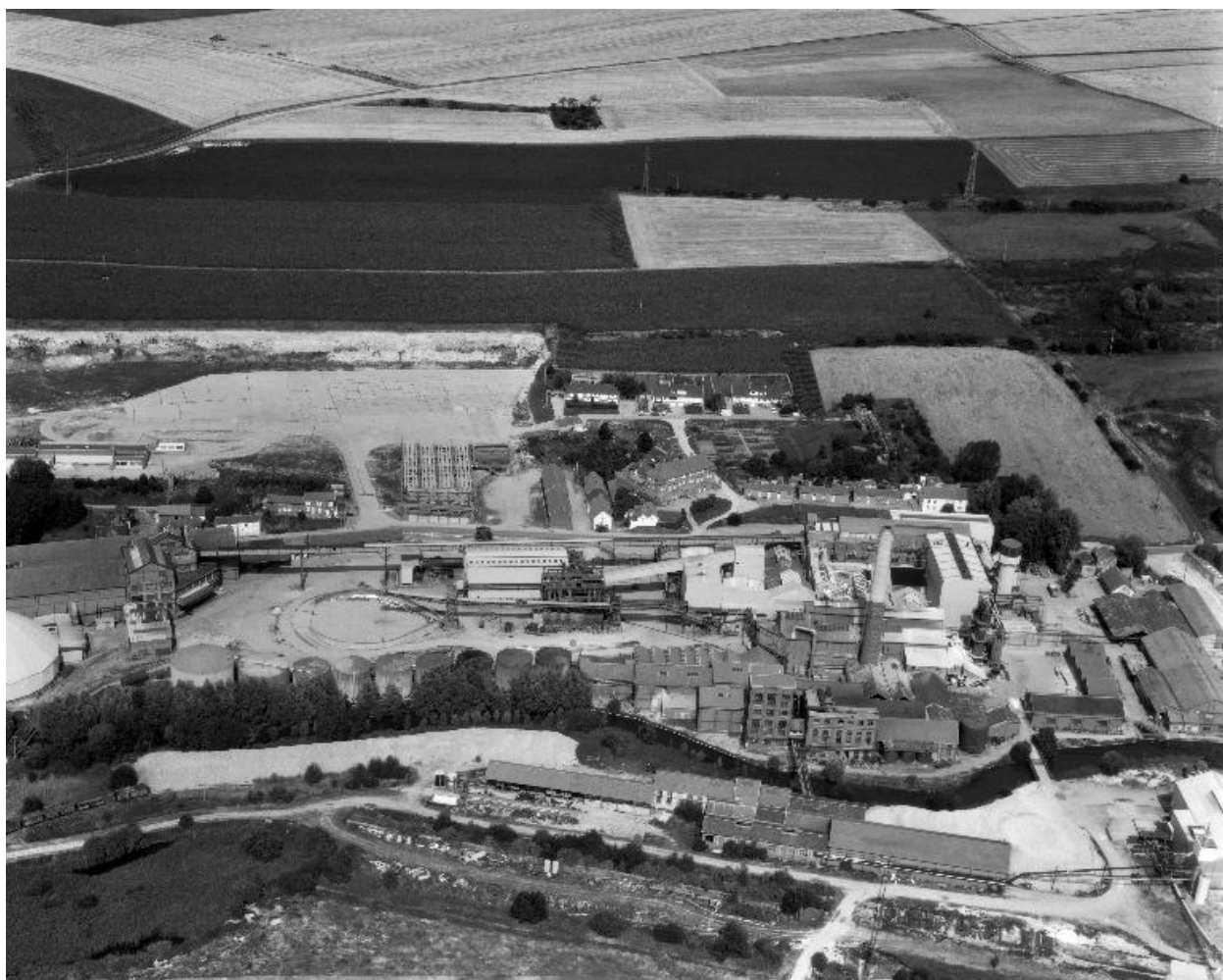
Vue aérienne, flanc sud-ouest.
