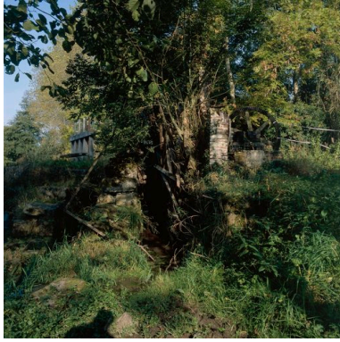
Les vestiges de la roue hydraulique verticale dans sa coulerie, vue de profil. Phot. Thierry Lefébure IVR22_20026001116XA
