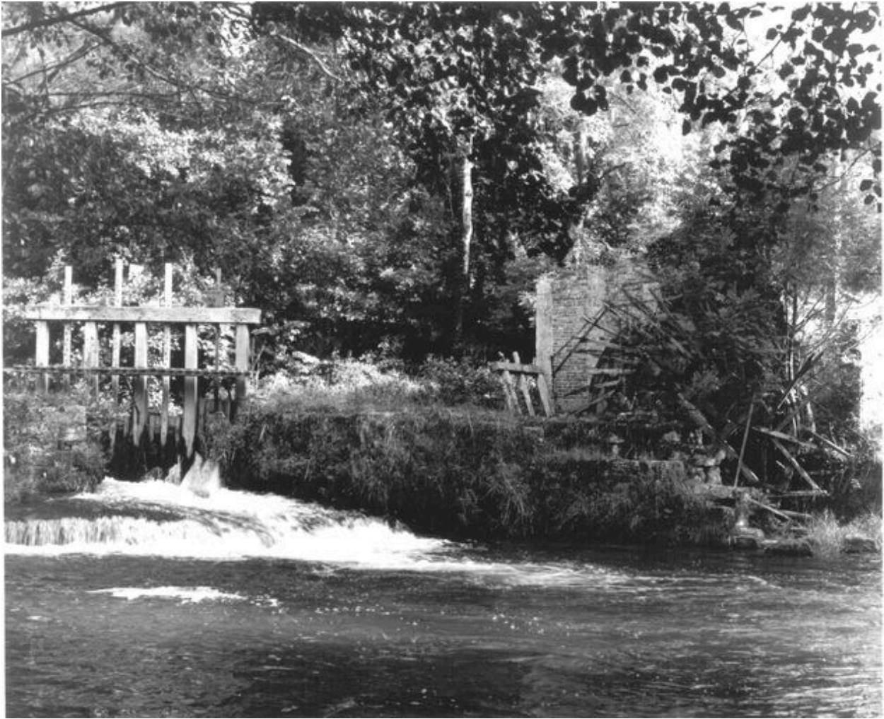
Les vestiges de la roue du moulin et du vannage de décharge.
