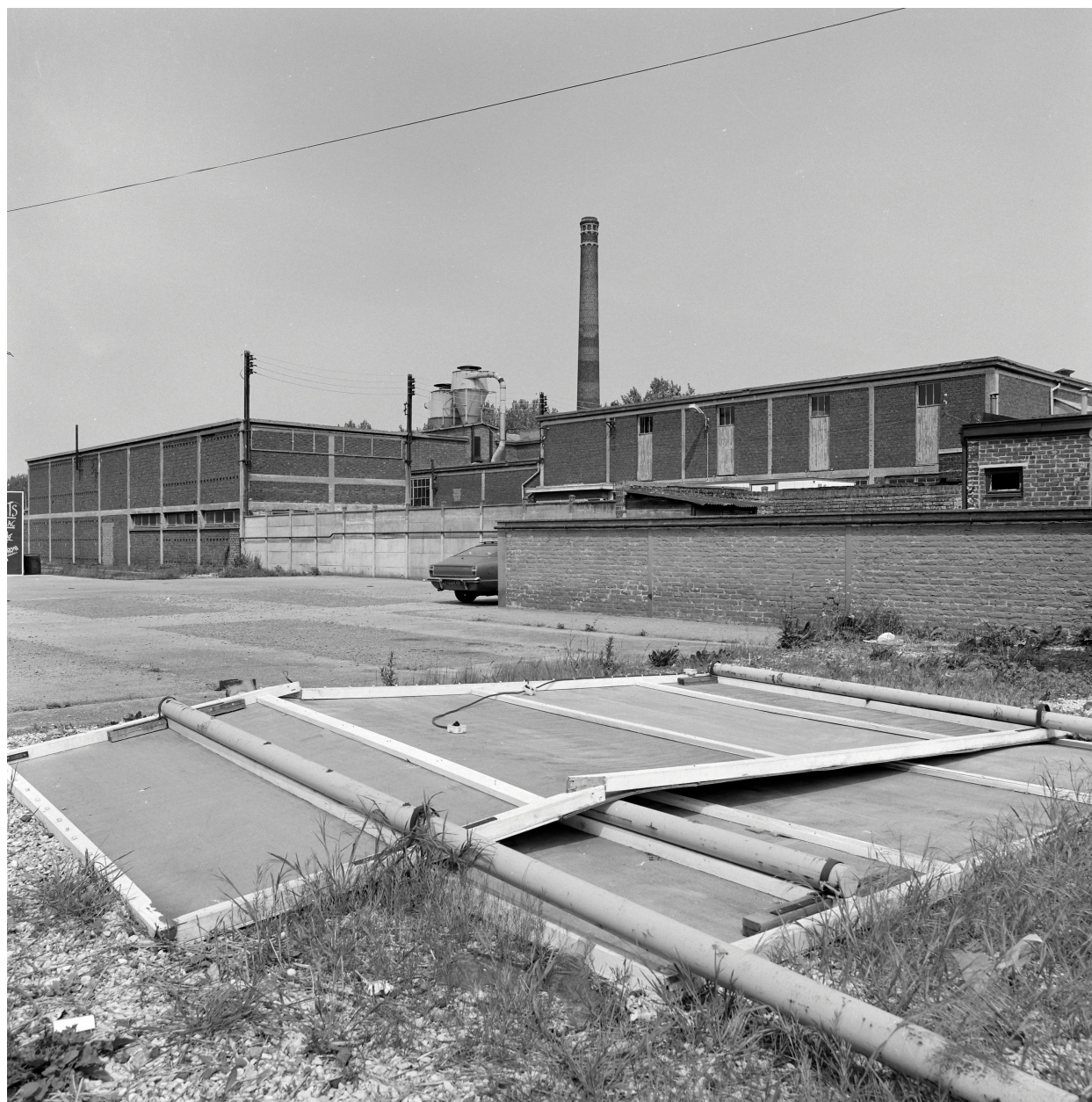
Vue générale vers le nord-est.
