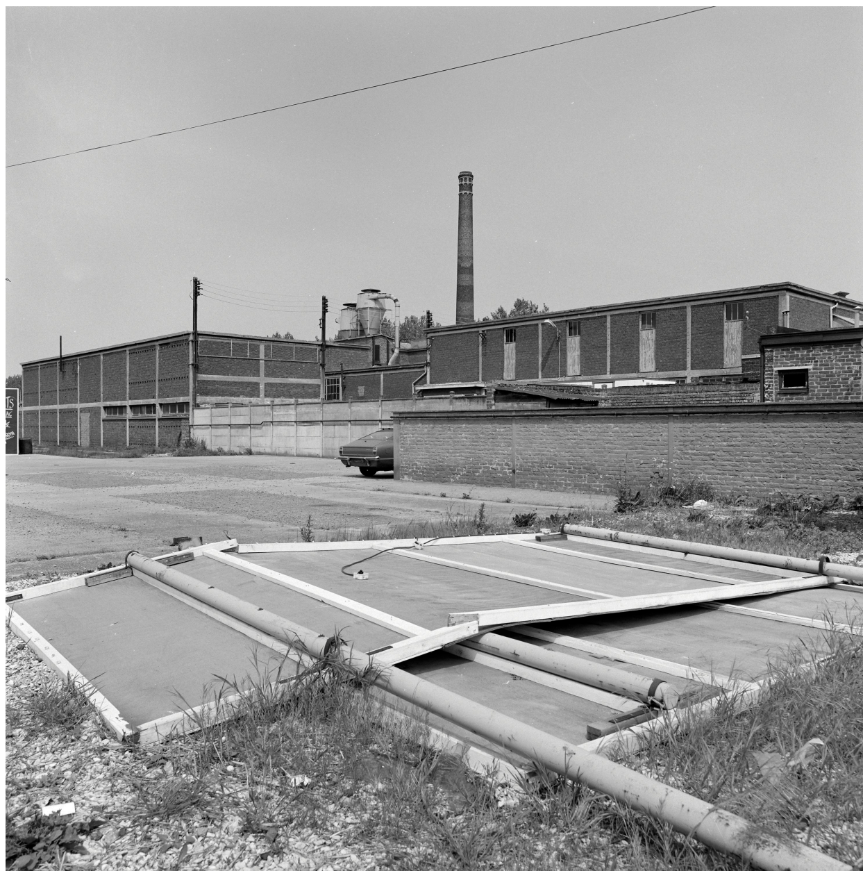
Vue générale vers le nord-est.
