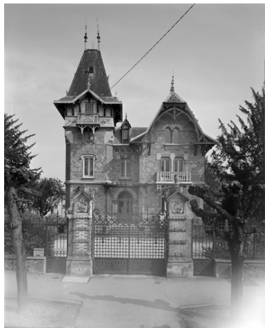
Vue générale depuis la rue. Phot. Thierry Lefébure IVR22_19940200316V
