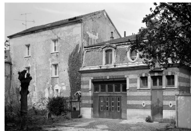
Les garages, anciennes écuries. Phot. Thierry Lefébure IVR22_19940200326X
