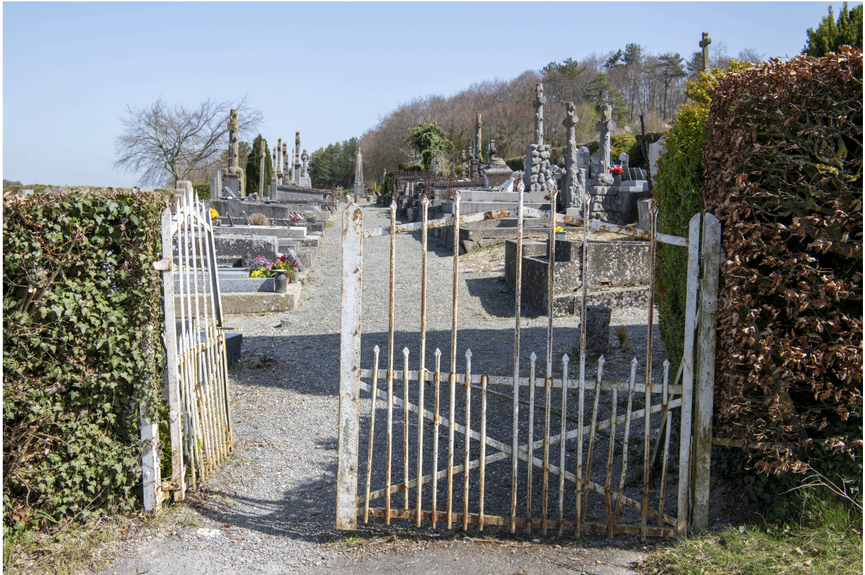
Entrée principale, côté ouest.
