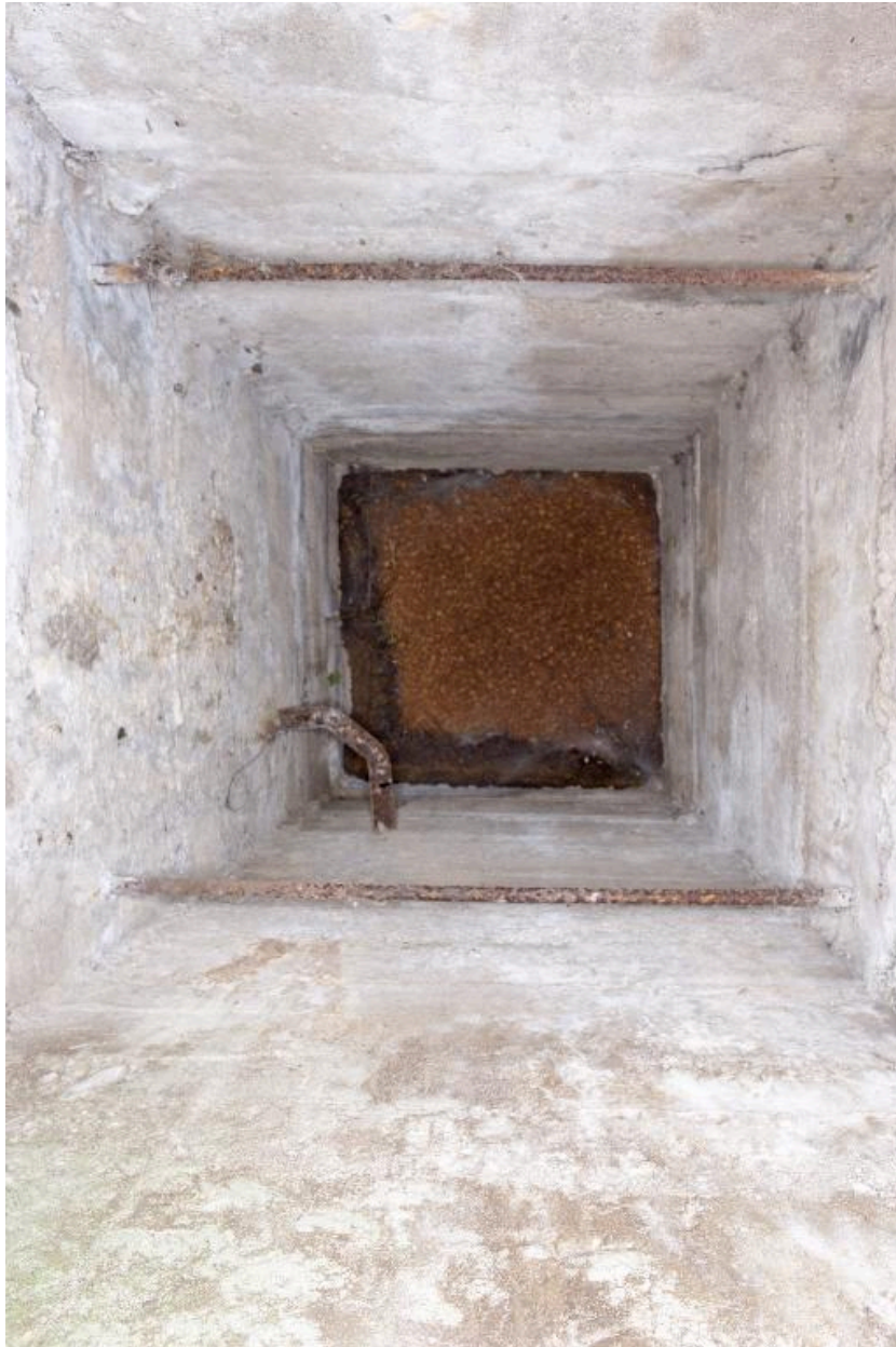
Vue zénithale du poste d'observation
