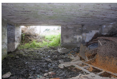
Vue intérieure de la chambre de tir, vers le sud. A gauche de l'embrasure d'entrée, l'accès au poste d'observation. Phot. Pierre Thibaut IVR32_20165900969NUCA
