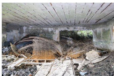
Vue intérieure de la chambre de tir vers l'embrasure de tir ouest Phot. Pierre Thibaut IVR32_20165900970NUCA
