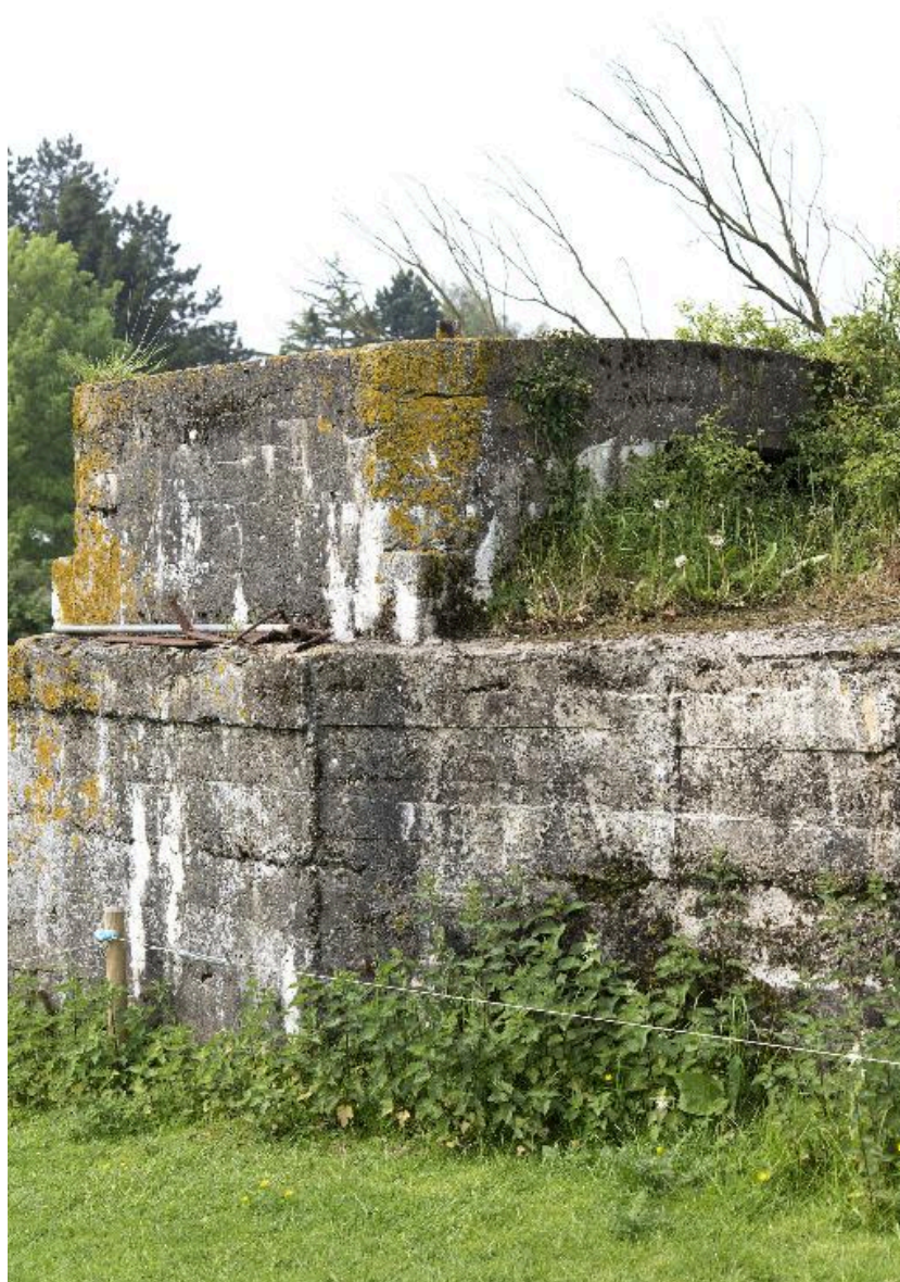
Détail du poste d'observation vers le sud-ouest
