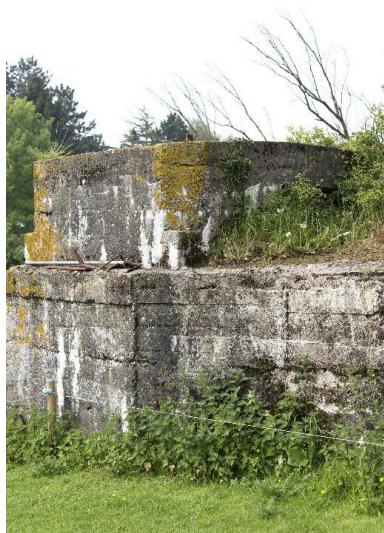
Détail du poste d'observation vers le sud-ouest Phot. Pierre Thibaut IVR32_20165901406NUCA
