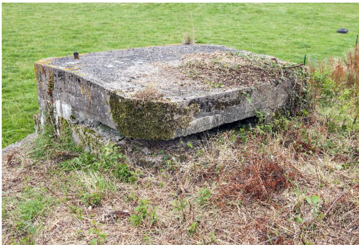
Depuis le couvrement : poste d'observation
