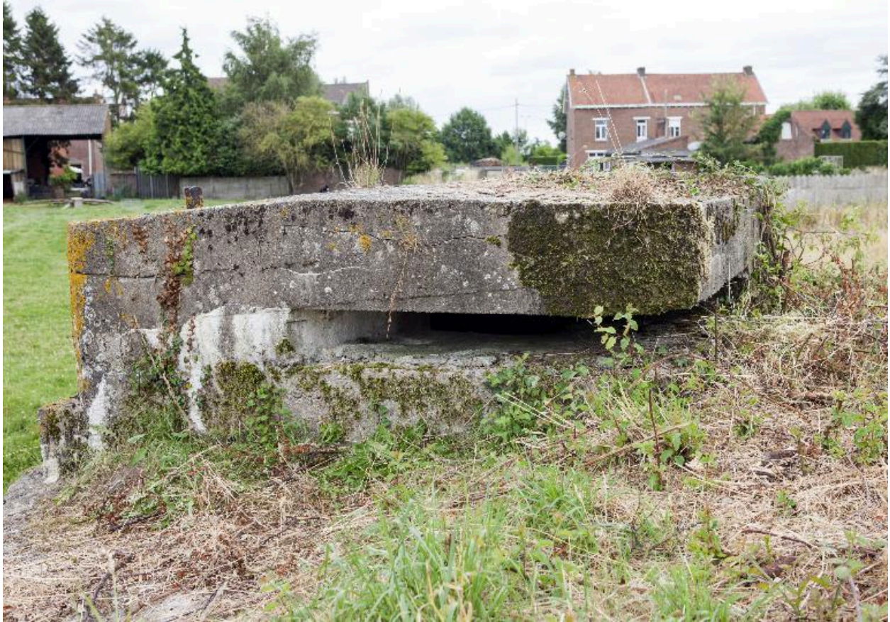
Depuis le couvrement, vers le sud : embrasure du poste d'observation
