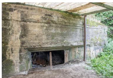
Elévation nord : Une des deux embrasures de tir. Phot. Pierre Thibaut IVR32_20165900977NUCA
