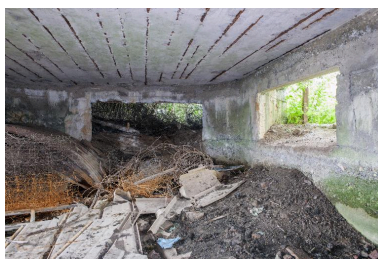
Vue intérieure de la chambre de tir vers le nord. Embrasures de tir Phot. Pierre Thibaut IVR32_20165900971NUCA
