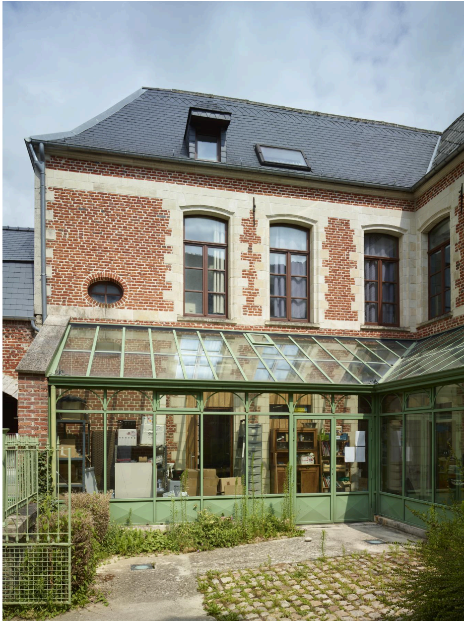
Façade arrière de l'aile sur rue, vue depuis la cour.
