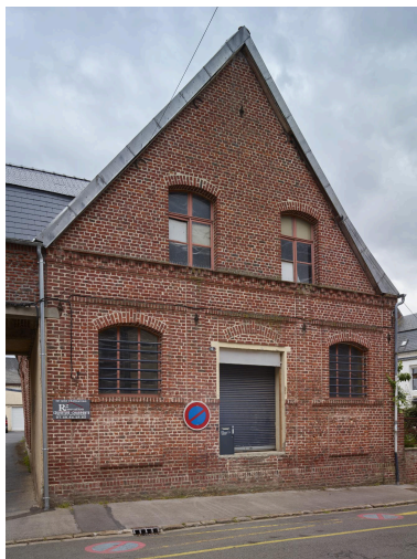
Détail de la façade de l'entrepôt.
