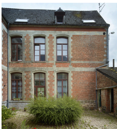
Façade sur cour de l'aile en retour d'équerre fermant la cour. Phot. Pierre Thibaut IVR32_20245900190NUCA
