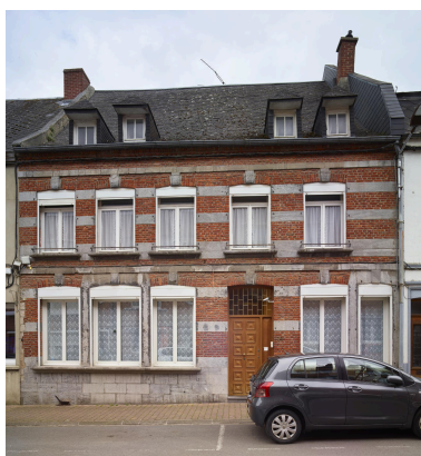
Maison de maître avec alternance de lits de briques et de pierre bleue - 14, rue Tanis.
