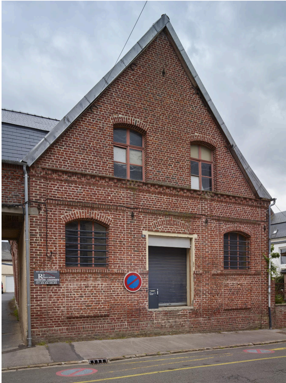
Détail de la façade de l'entrepôt.
