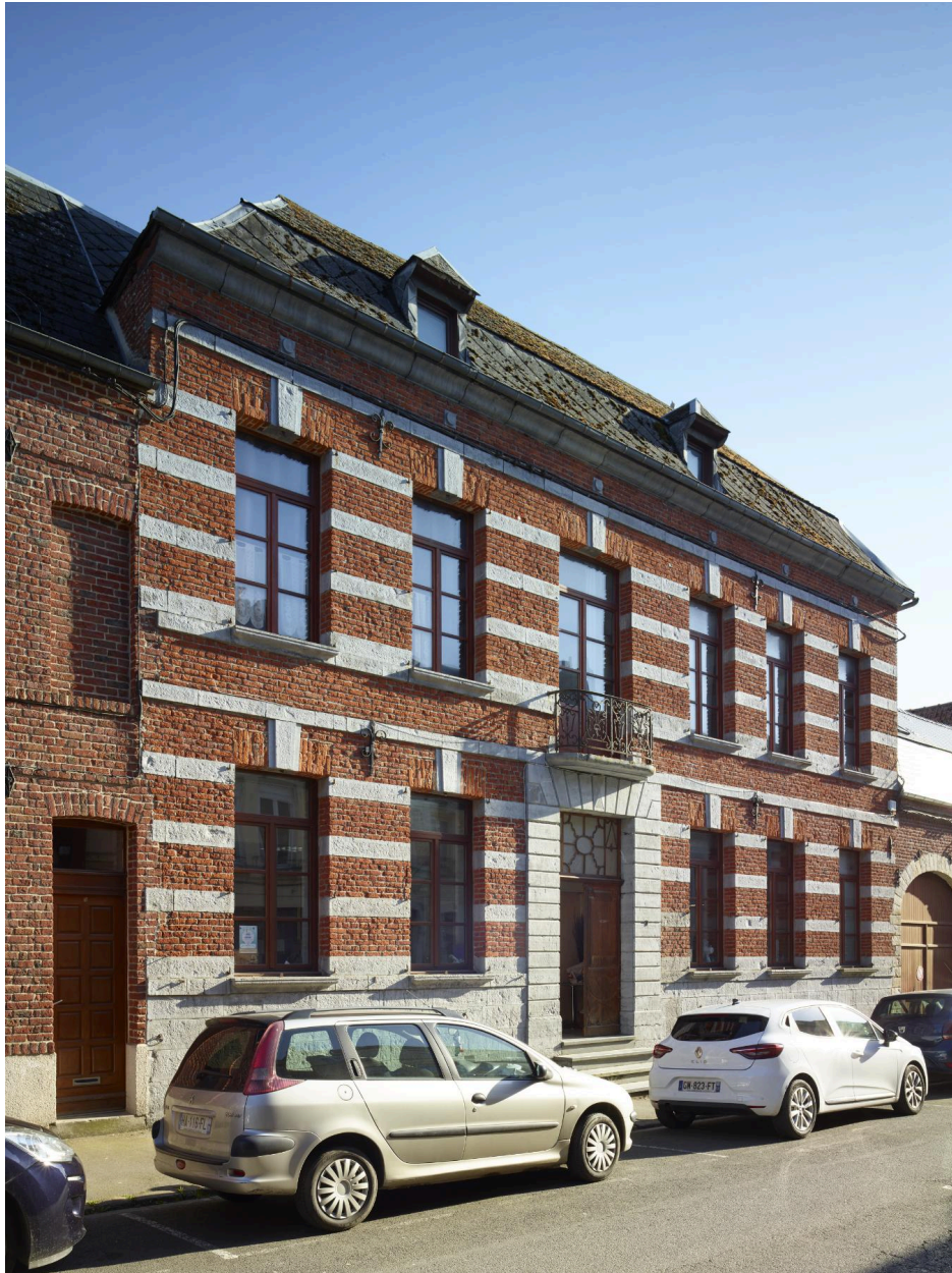
Façade principale de la maison sur la rue George-V. Vue orientée nord-est/sud-ouest.
