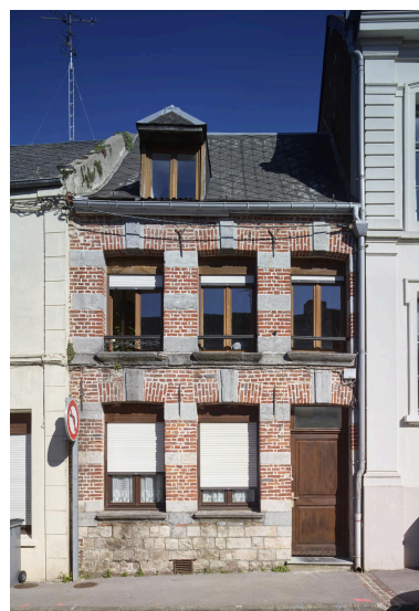
Maison avec alternance de lits de briques et de pierre bleue - 28, rue Thiers.
