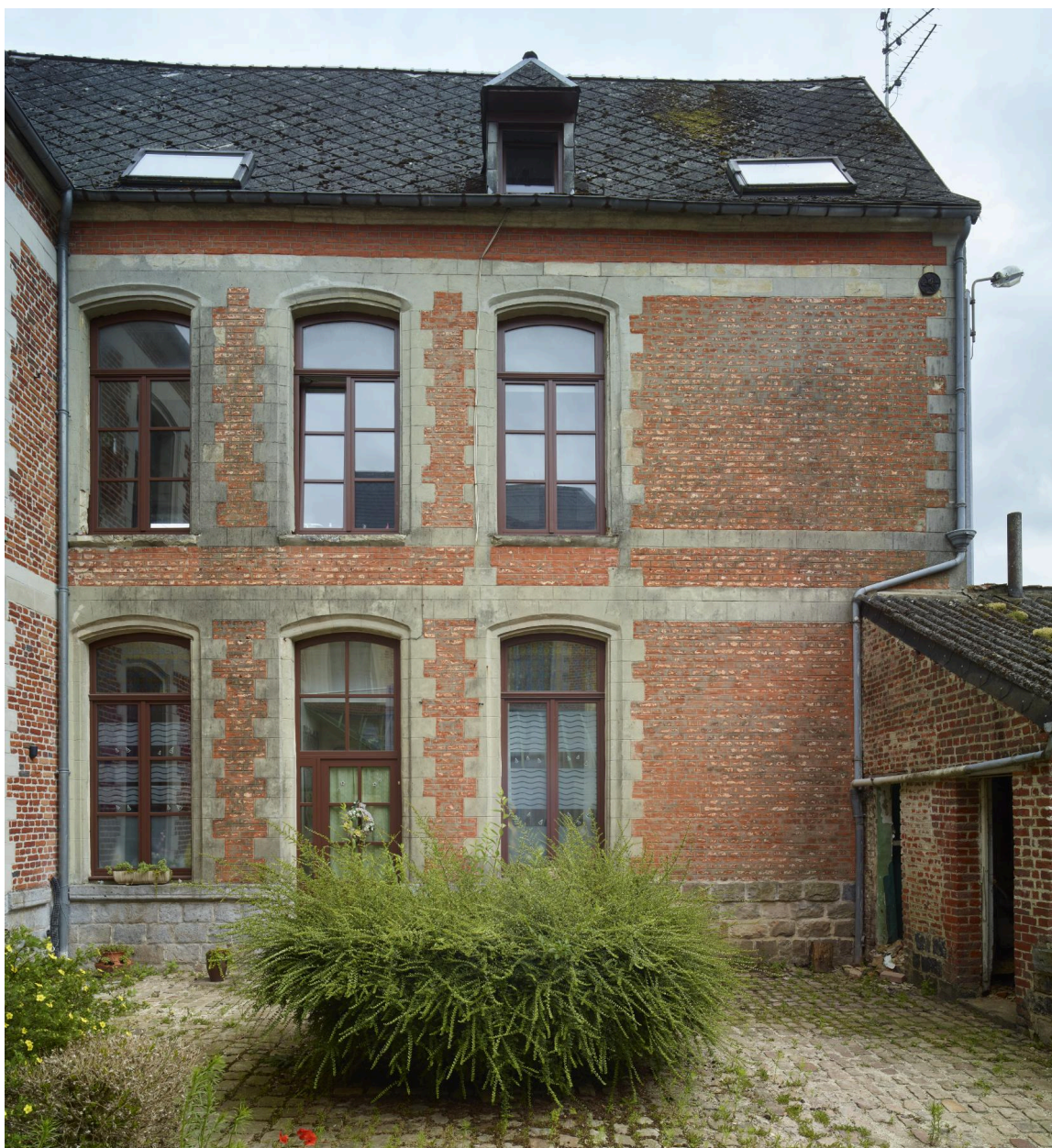
Façade sur cour de l'aile en retour d'équerre fermant la cour.
