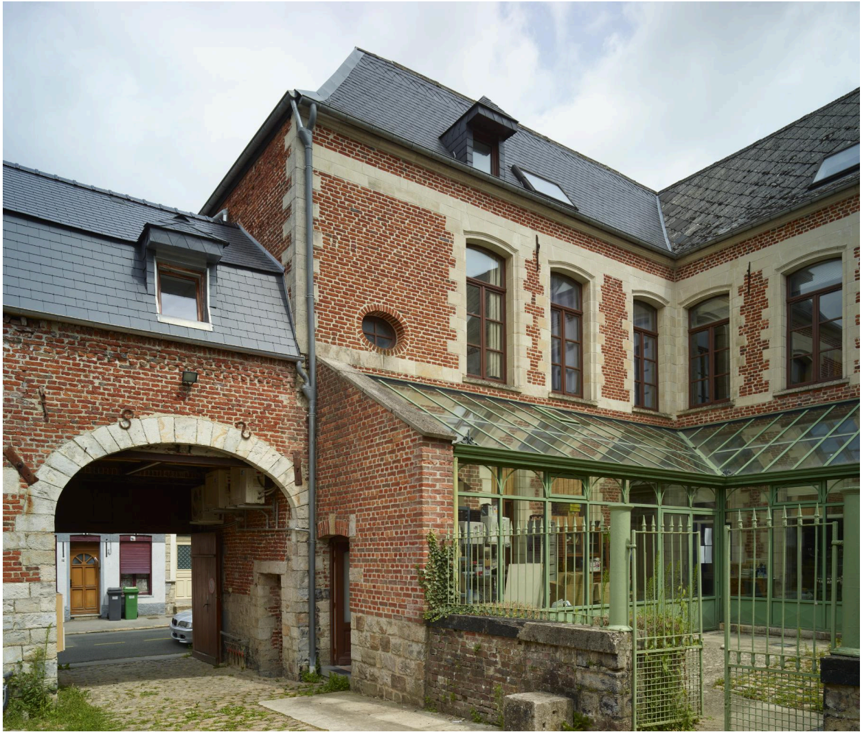
Détail de la jonction entre la maison et l'aile accueillant le porche : vue depuis la cour.
