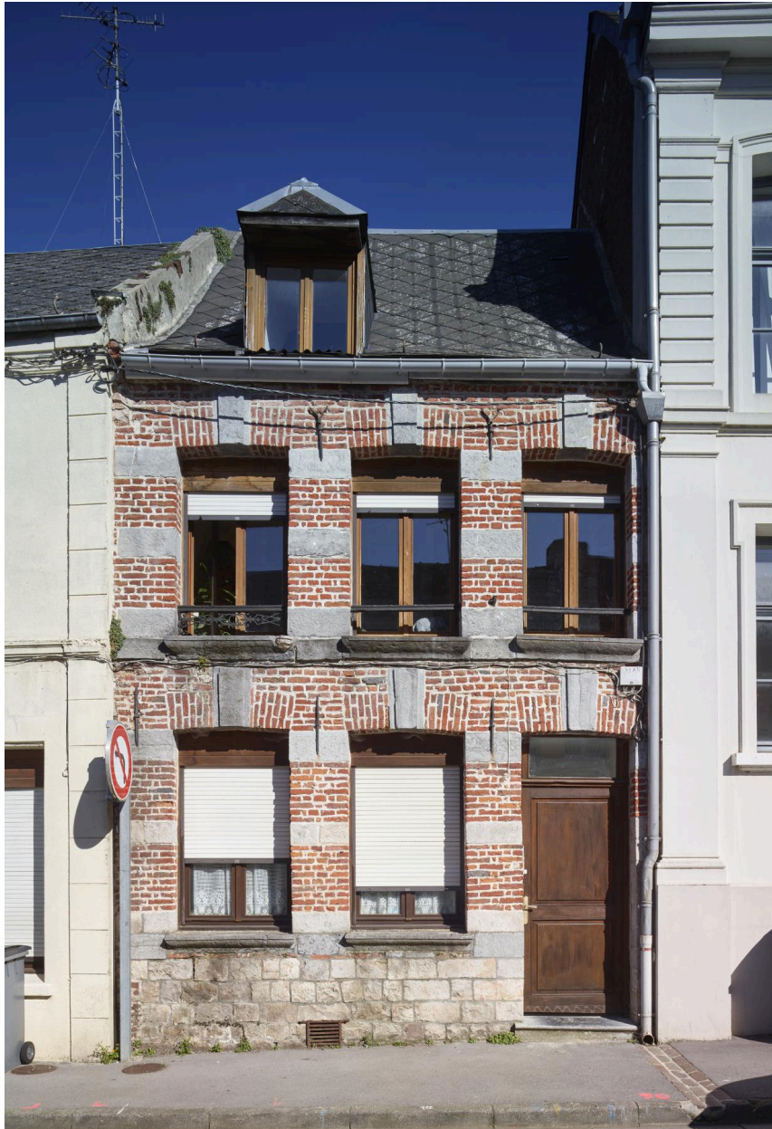
Maison avec alternance de lits de briques et de pierre bleue - 28, rue Thiers.
