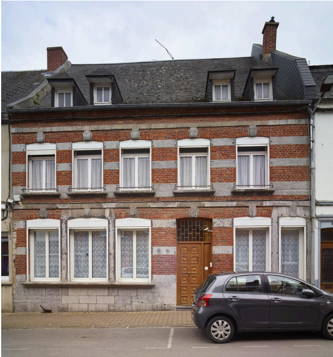
Maison de maître avec alternance de lits de briques et de pierre bleue - 14, rue Tanis.
