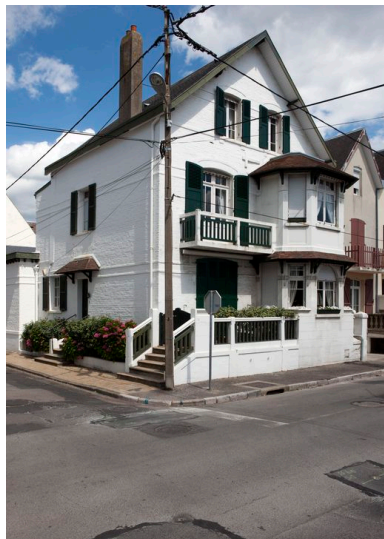
Vue générale. Phot. Pierre Thibaut IVR31_20146202200NUCA
