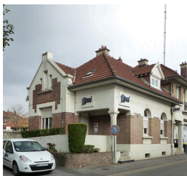
Vue de l'ancien commissariat de police. Phot. Isabelle Barbedor IVR32_20210205141NUCA
